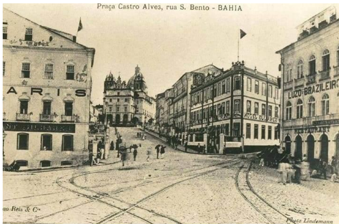
Figura 8: Vista da Ladeira de São Bento
