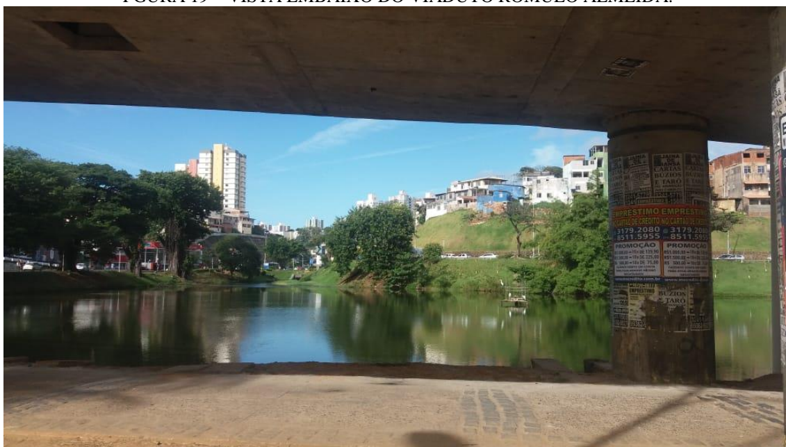
FIGURA 19 – VISTA EMBAIXO DO VIADUTO RÔMULO ALMEIDA.
