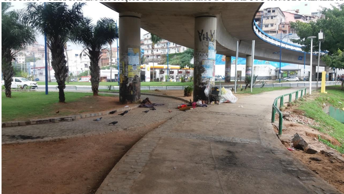
FIGURA 5 – PESSOAS EM SITUAÇÃO DE RUA EMBAIXO DO VIADUTO RÔMULO ALMEIDA.
