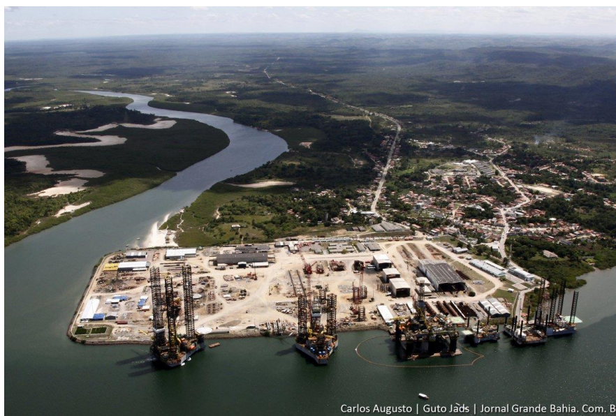
Figura 3. Vista aérea do canteiro de obras da Petrobrás e de plataformas de petróleo em Maragojipe, Bahia. Fonte: Arquivo Jornal Grande Bahia.
