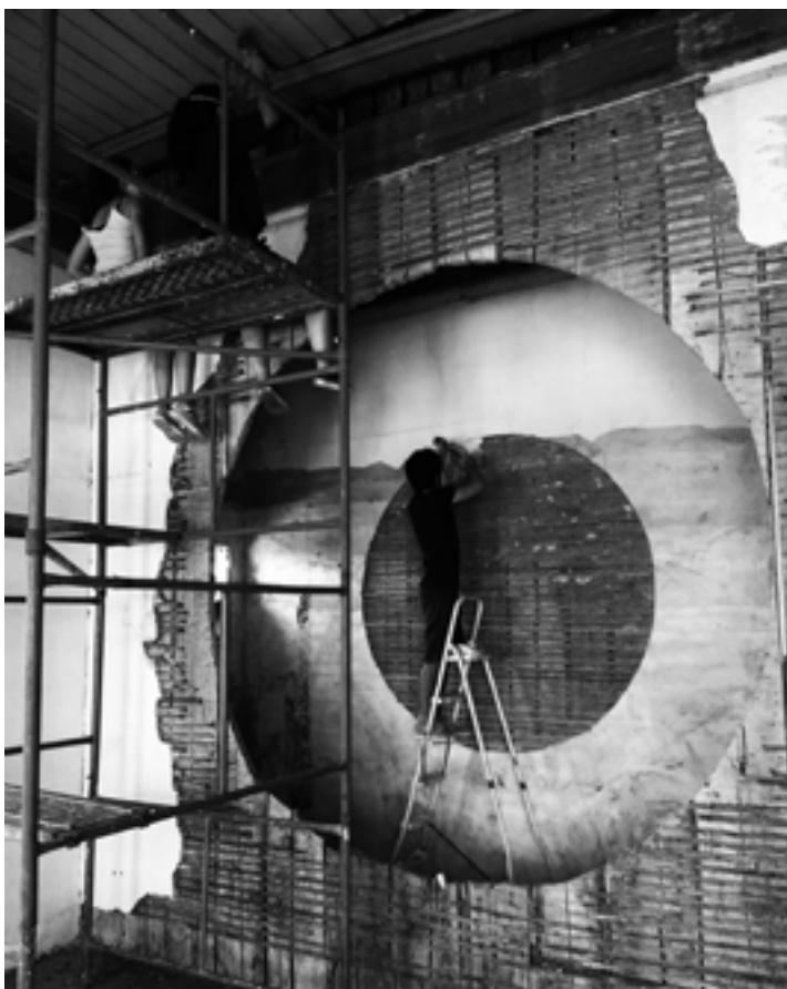
Figura 5 – Construção dos furos na Ksa Rosa. Fonte: acervo Ksa Rosa.
