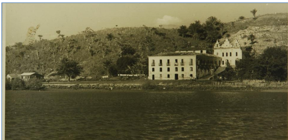
Figura 9 – Vista geral do Sobrado e Capela – Engenho Freguesia.
