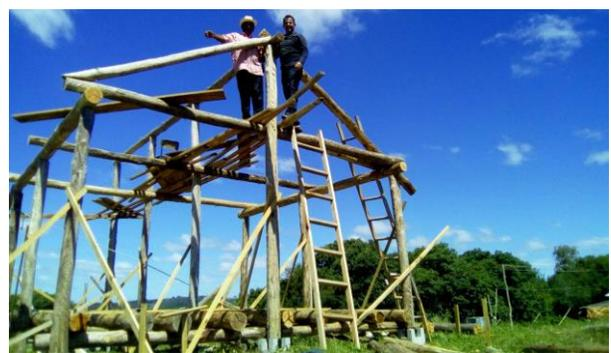
Figura 25 - Casas em Processo de Montagem de Estruturas e Telhado, 2018. Fonte: Acervo do Autor e NE.
