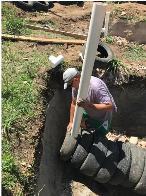
Figura 35 - Preenchimento da camada de entulho e instalação da tubulação. Fonte: Acervo do Autor.
