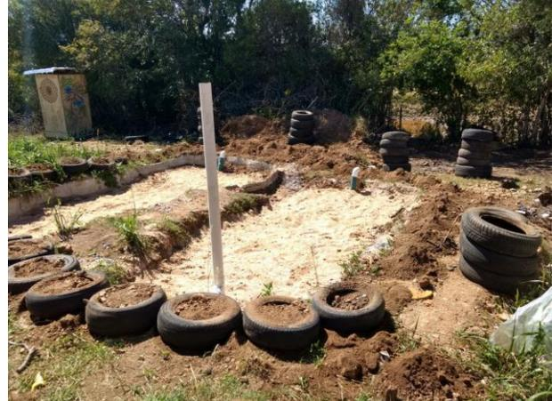
**Figura 37 - Preenchimento com areia fina, nivelamento e colocação de pneus para borda. Fonte: Acervo do autor.**
