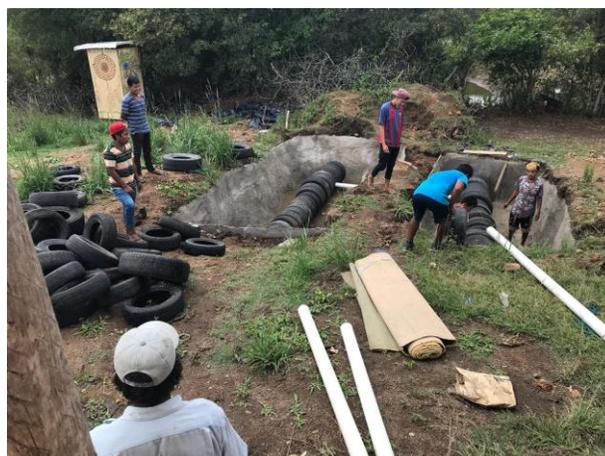
**Figura 34 - Concretagem das Bacias e Montagem câmaras. Fonte: Acervo do Autor,**
