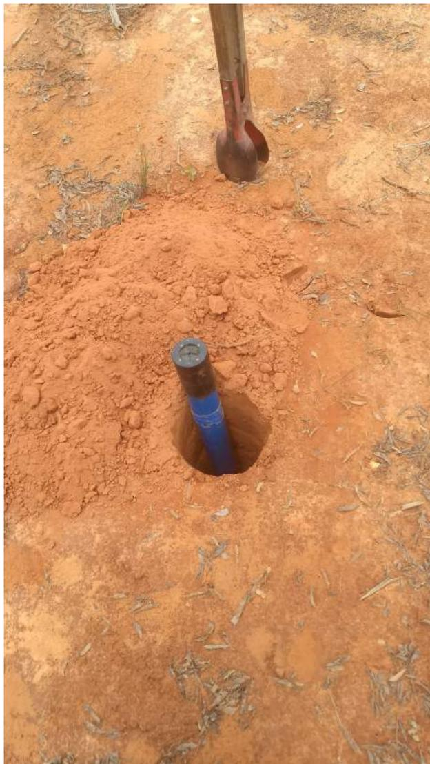
Figura 4.3: Instalação do magnetômetro vertical.
