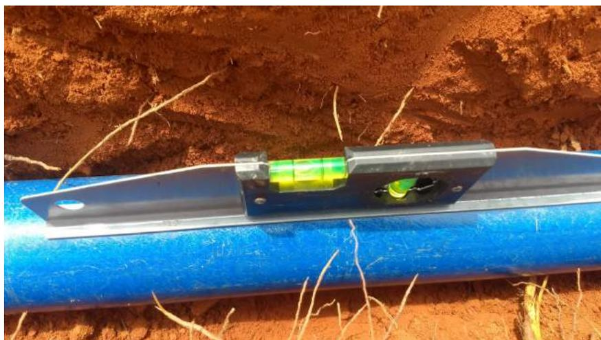
Figura 4.4: Instalação de magnetômetro horizontal.
