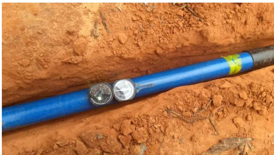
Figura 4.5: Instalação de magnetômetro horizontal.
