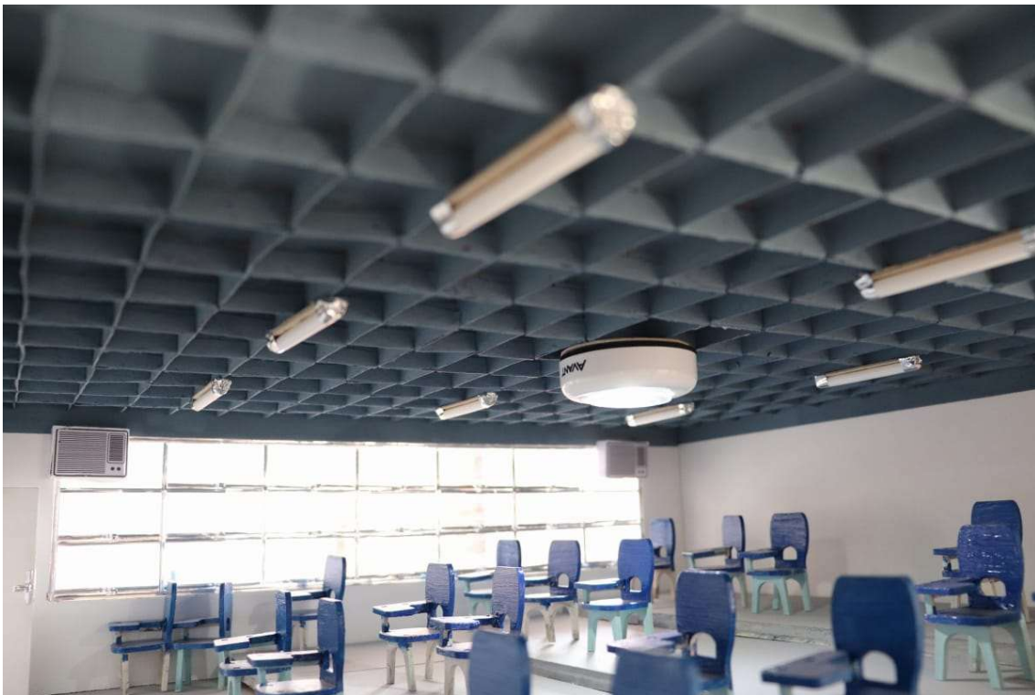
Figura 6: Andar sem revestimento acústico
