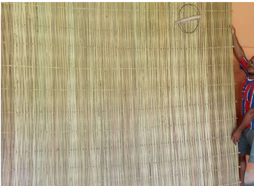
Figura 10: Esteira de fibra de dendê para revestimento acústico da sala de aula, desenvolvida por comunidade quilombola. Moreré, BA.
