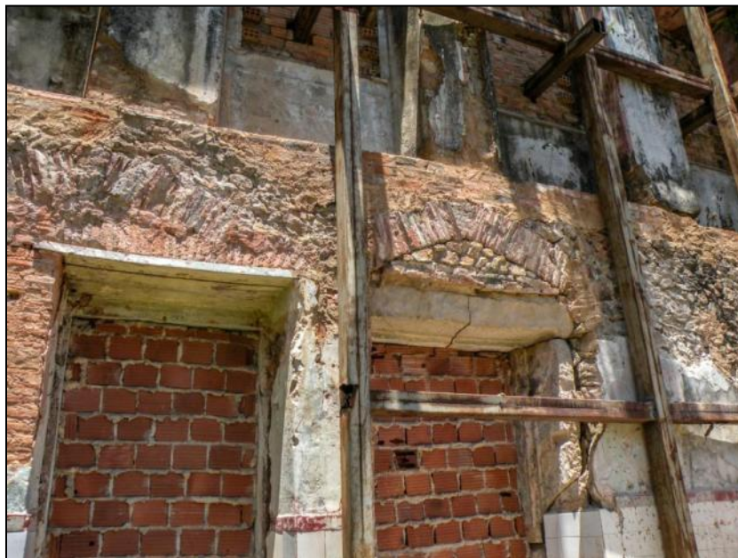
Figura 21: Interior da fachada da casa 21
