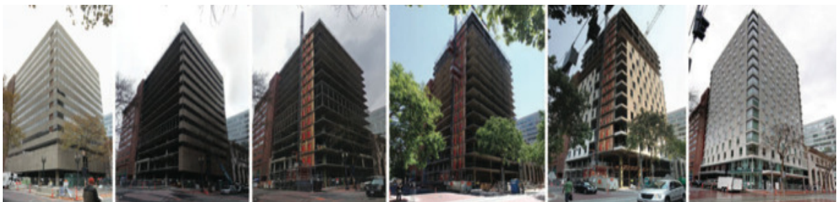
Figura 28 – Sequência do processo de reforma do Courtyard by Marriott
