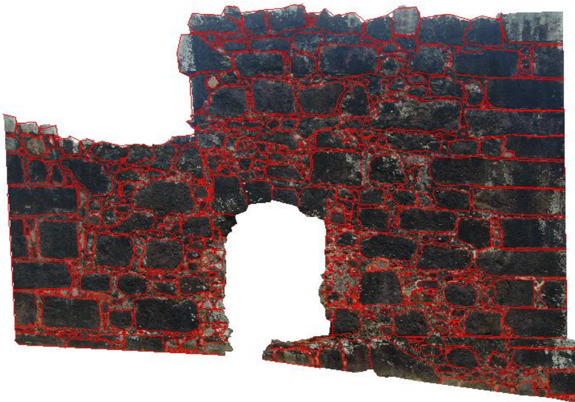
Figura 59. Desenho produzido no AutoCAD sobre ortofoto da parede. Fonte: Costa e Amorim (2009).
