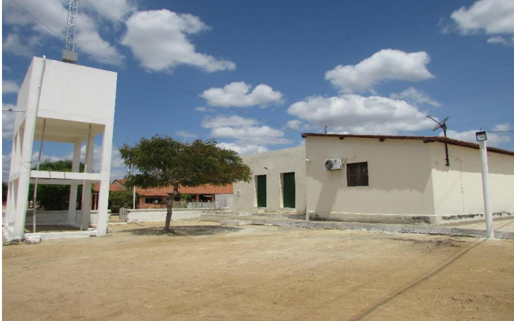
Figura 16 – Vista da frente do salão comunitário. EBJ, 2019
