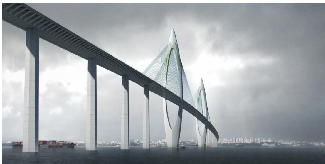
Figura 77 – Aspectos visuais da Ponte Salvador-Itaparica propostos pelo projeto da obra.
