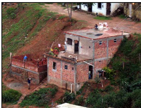
Figura 15: Acompanhamento da autoconstrução Foto: Anderson Gomes de Oliveira
