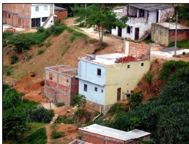
Figura 16: Acompanhamento da autoconstrução Foto: Anderson Gomes de Oliveira
