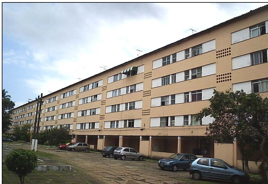
Figura 9: Padrão de edificação implantado pelos IAPs em Salvador Foto: Anderson Gomes de Oliveira
