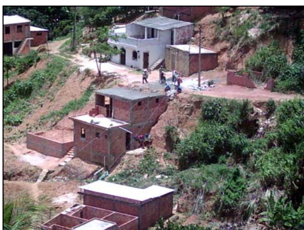
Figura 14: Acompanhamento da autoconstrução Foto: Anderson Gomes de Oliveira
