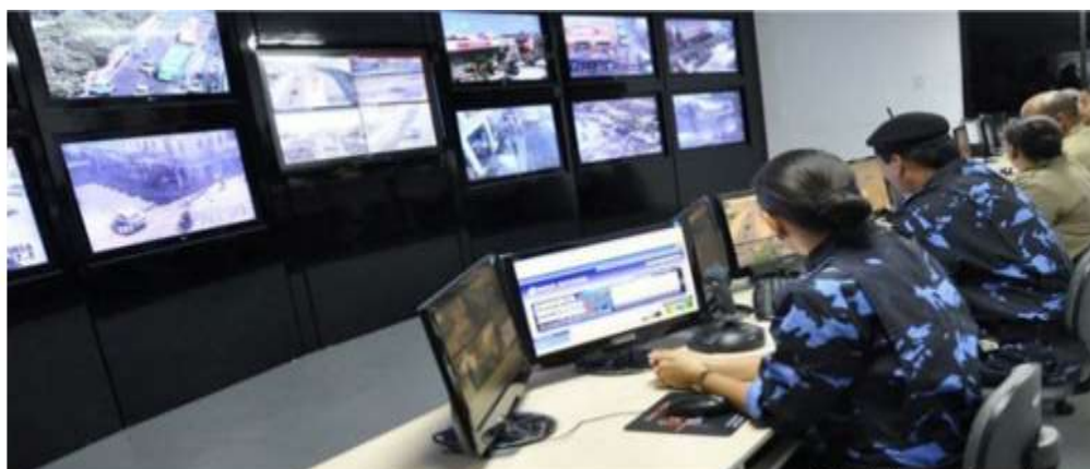
Figura 5 – Central de Controle de Videomonitoramento
