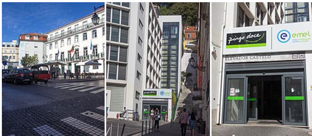
Figura 10- Segunda etapa Elevador Castelo. 651
