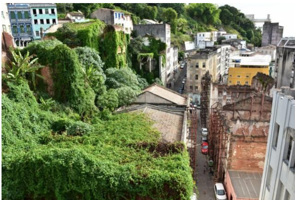
Figura 81 - Imóveis degradados no Centro Histórico de Salvador.
