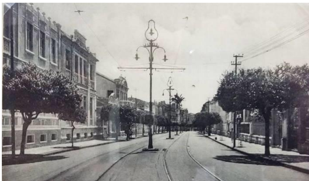
Figura 70 - Avenida Sete de Setembro (Vitória).
