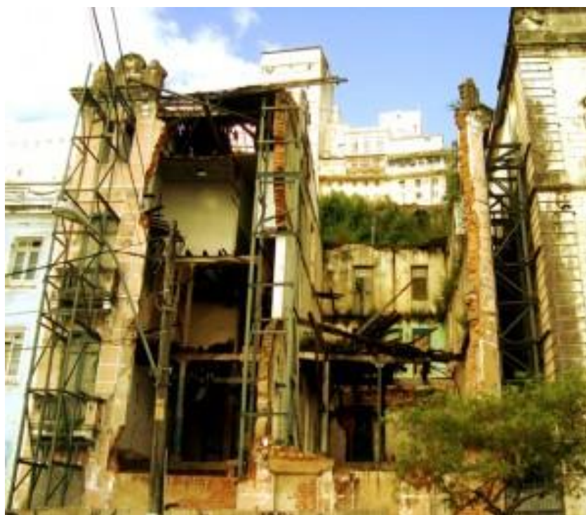
Figura 79 - Casarão abandonado no Centro Histórico de Salvador (a).
