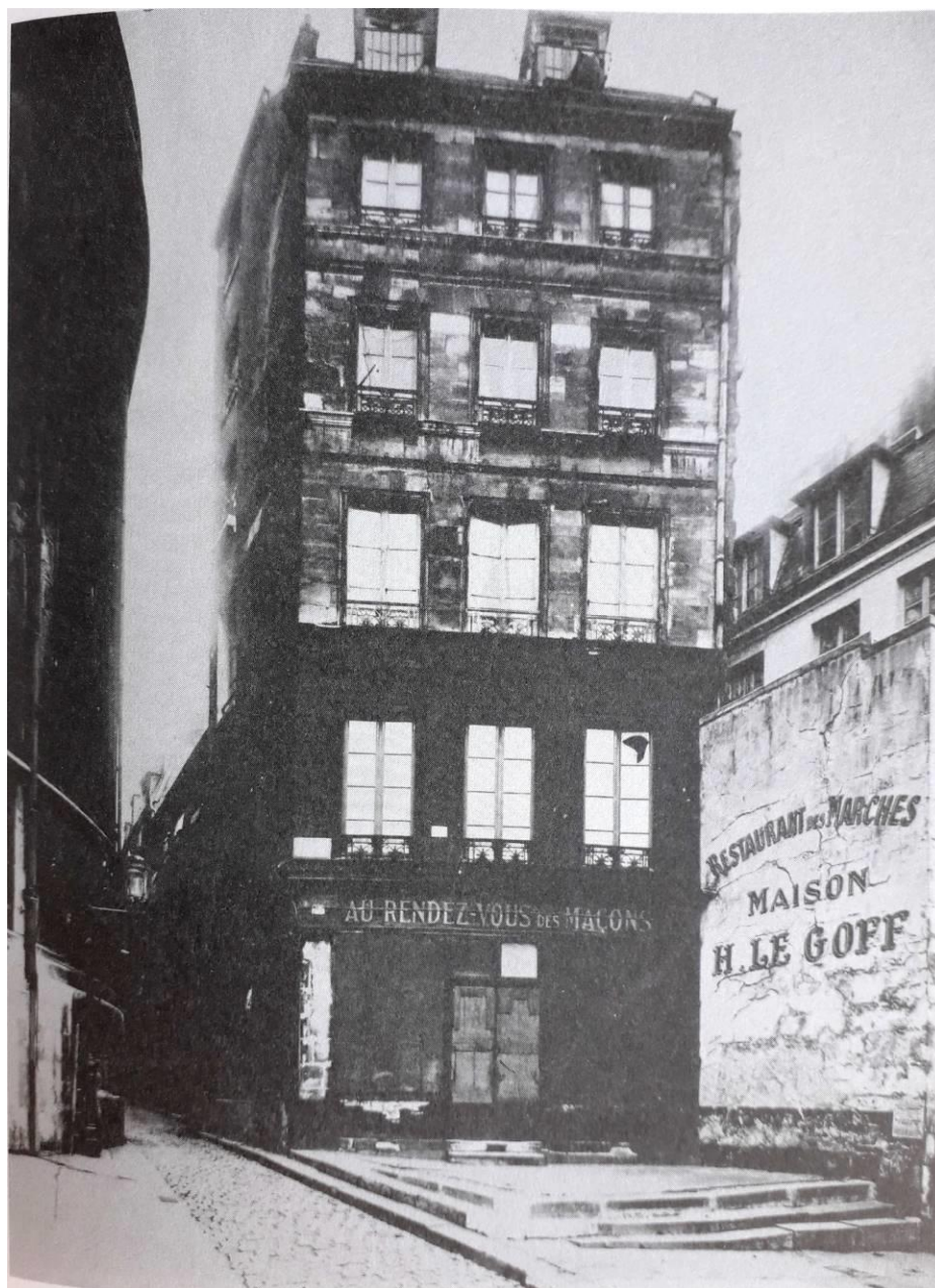
Figura 101 - Rua no Marais antes das intervenções - 10 Rue de Brosse (1942).
