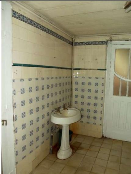
Fig.1: Sala de banho com paredes divisórias em tabique de fasquio e revestida com azulejos.
