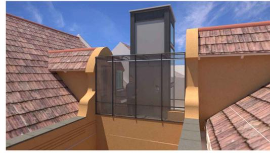
Estrutura de aço e vidro. O passadiço possui janelas pivotantes.
