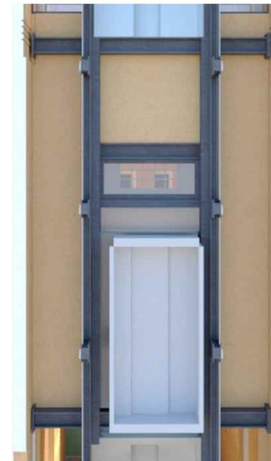
A caixa tem estrutura autossustentada e para ancorar no prédio, há vigas metálicas conectadas às paredes externas no nível do piso.
