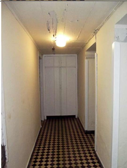
Ao fundo, um armário embutido em madeira. O piso desta ala é todo em ladrilhos hidráulicos com rodapés. O forro é em madeira com junta seca e encoberto por tinta branca.
