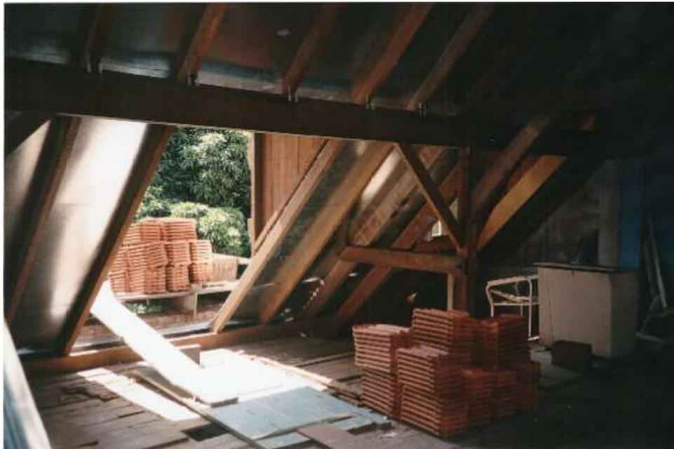
Na obra de recuperação da cobertura, foram retirados os revestimentos internos em madeira, substituídas as peças danificadas do madeiramento por novas, assim como o fechamento de todas as trapeiras.
