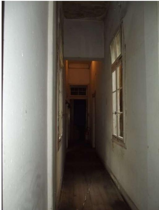
O A25, conforme mencionado, faz parte da circulação e é o trecho correspondente ao passadiço de ligação entre os dois blocos. Apesar do piso de madeira neste trecho, a estrutura é em laje mista de alvenaria de tijolos maciços e vigas de ferro em T invertido.
