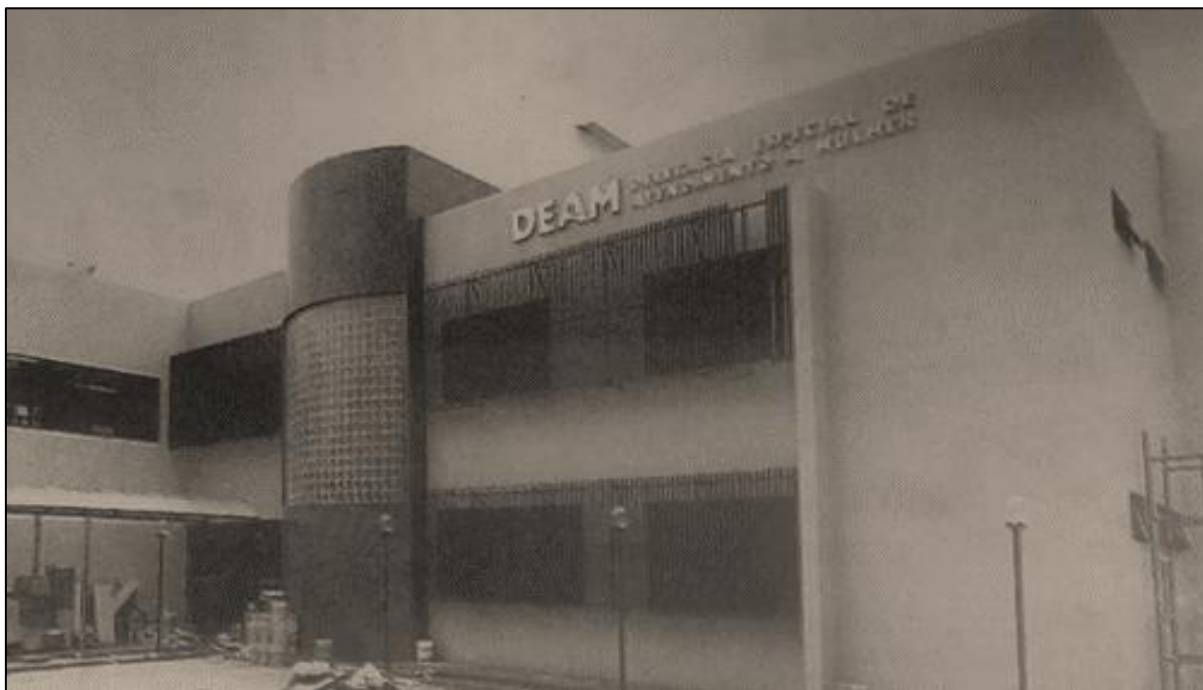
Figura 6. Salvador-BA: Fachada do prédio da Delegacia Especializada em Atendimento às Mulheres, no bairro Brotas– 2002
