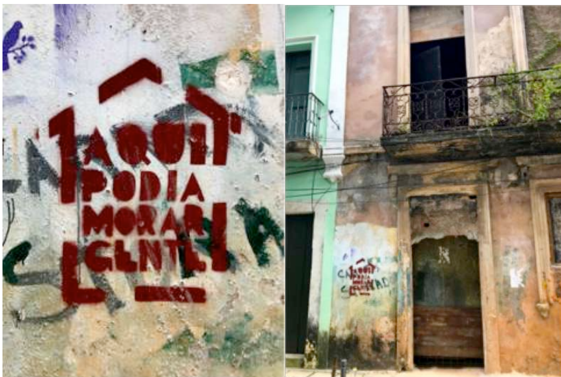
Fot. 21 e 22. Casarão abandonado na Rua do Bispo. Fonte: arquivo pessoal.
