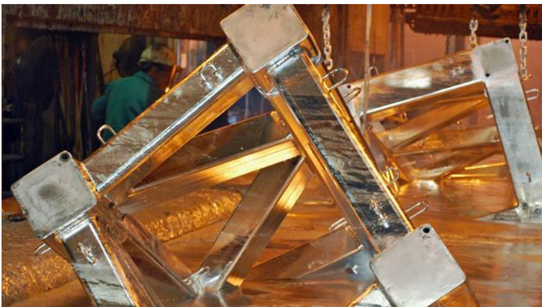
Figura 5 – Estrutura metálica sendo revestida por imersão a quente em zinco fundido.
