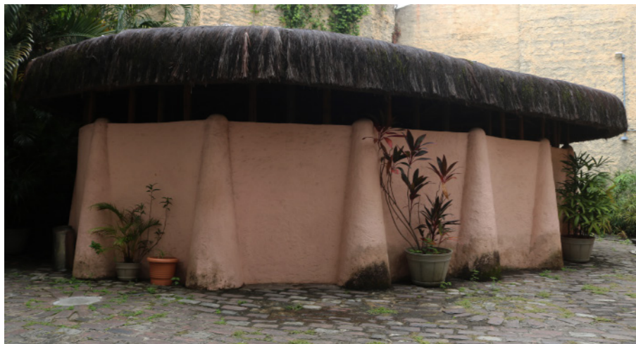
Fig. 160 Pátio da Casa do Benin e o 'Tata-Somba'
