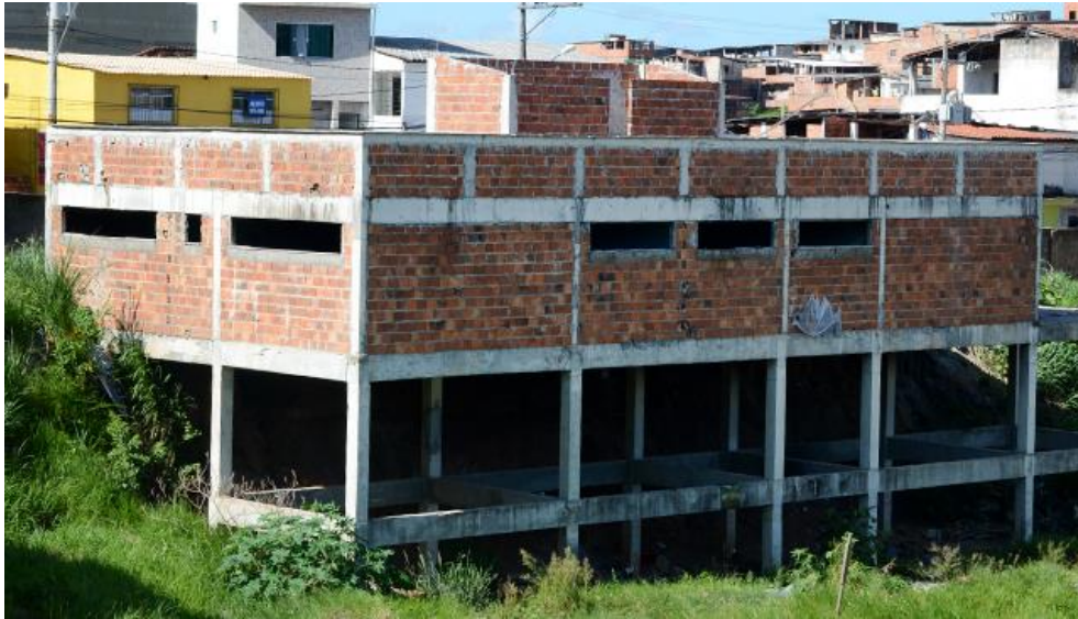
Figura 3: Prédio em construção para Base Comunitária de Segurança da Engomadeira
