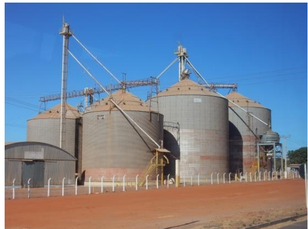
Figura 30 – Silos - armazenamento de grãos – Barreiras - BA
