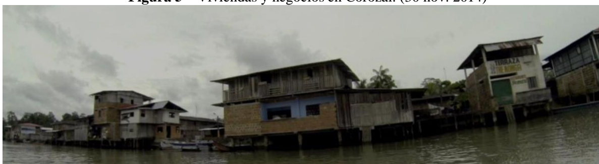
Figura 5 – Viviendas y negocios en Corozal. (30 nov. 2014)
