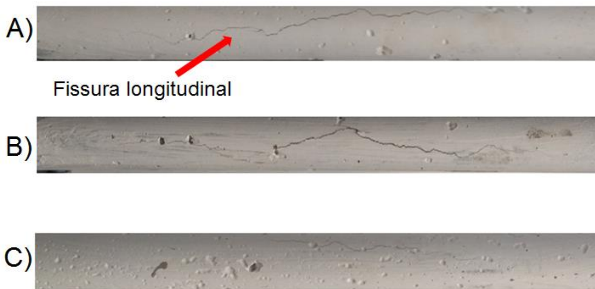
Figura 57. Falha longitudinal do concreto armado com vergalhões de (A) GFRP-P, (B) GFRP-V e (C) GFRP-E submetidos a 300°C.
