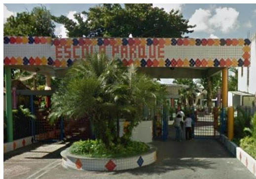
Figura 2 – Fachada Escola Parque Fonte: Site Educação BA
