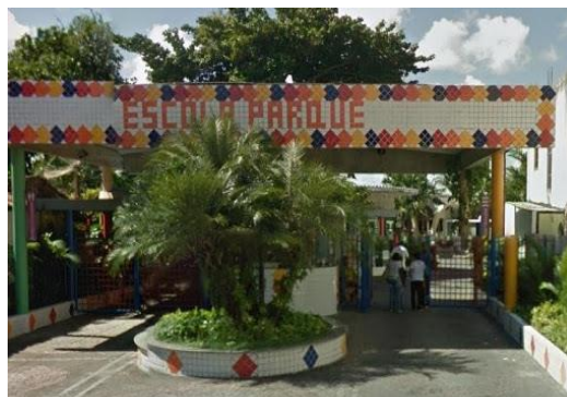
Figura 2 – Fachada Escola Parque Fonte: Site Educação BA
