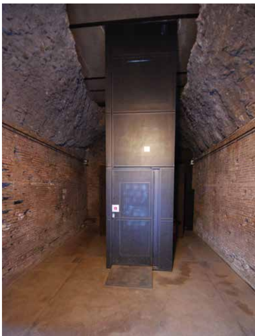
Figura 52 Elevador interno em aço dos Mercados de Trajano Fonte: Rodrigo Baeta (2011).
