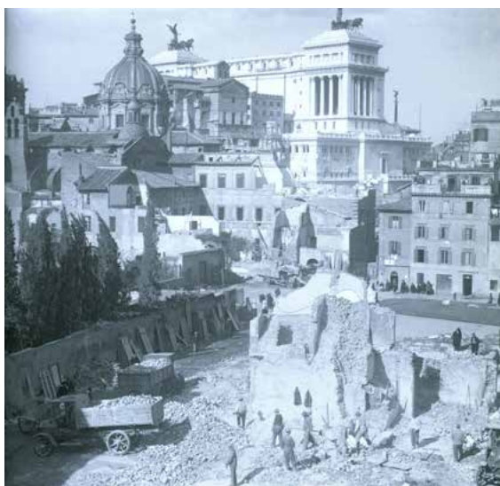
Figura 315 Destruições no Fórum de Trajano e no Fórum Romano em 1931 Fonte: Insolera; Sette (2003, p. 80).
