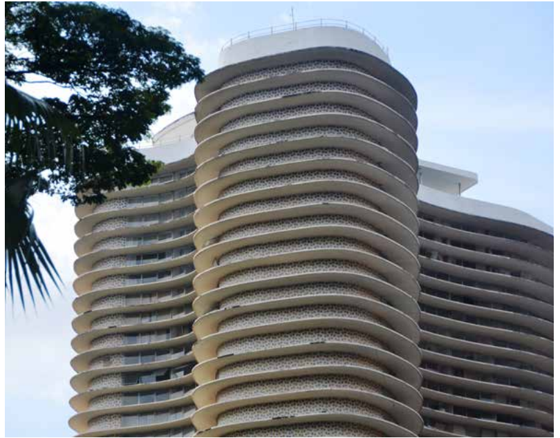
Figura 203 Detalhe dos últimos andares do Edifício Niemeyer Fonte: Rodrigo Baeta (2014).
