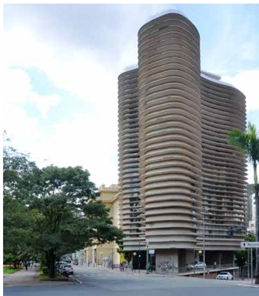
Figura 210 Base do Edifício Niemeyer e a preexistência historicista em sua interface com a antiga Secretaria de Segurança Pública, atual Centro Cultural Banco do Brasil. Fonte: Rodrigo Baeta (2014).
