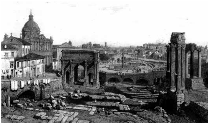
Figura 278 Félix Benoist, 1870. Vista do Fórum, com destaque para o Arco de Settimo Severo, colunas de Vespasiano e Saturno liberados e habitando o mesmo “buraco”
