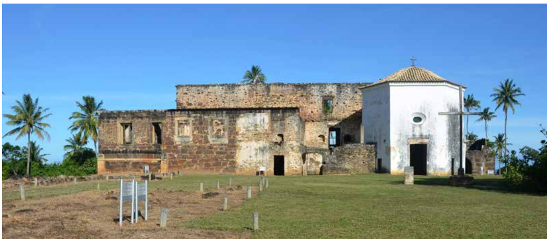
Figura 54 Ruínas consolidadas da Casa da Torre de Garcia D'ávila, com destaque para a capela centralizada restaurada, à direita Fonte: Rodrigo Baeta (2014).
