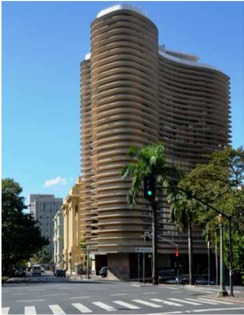
Figura 202 Edifício Niemeyer capturado a partir da Avenida Cristóvão Colombo Fonte: Rodrigo Baeta (2016).
