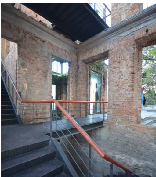
Figura 122 Interior oco do Parque das Ruínas, com escadas e passarelas metálicas Fonte: Rodrigo Baeta (2014).
