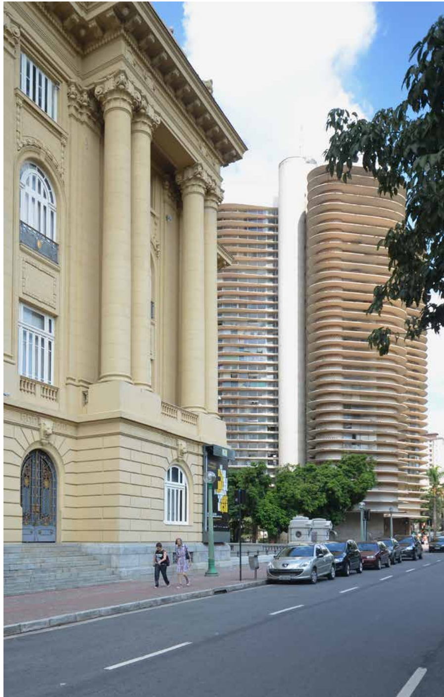
Figura 208 Centro Cultural Banco do Brasil e o Edifício Niemeyer Fonte: Rodrigo Baeta (2014).
