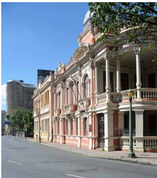
Figura 209 Palacete Dantas e Solar Narbona, na Avenida Cristóvão Colombo. À frente aparece o Edifício Niemeyer Fonte: Rodrigo Baeta (2016).
