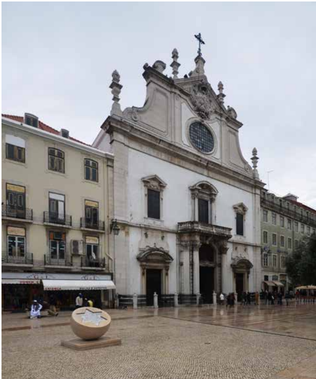
Figura 89 Fachada restaurada da Igreja de São Domingos, em Lisboa Fonte: Rodrigo Baeta (2012).
