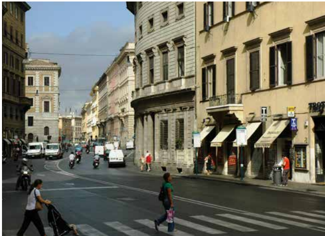
Figura 237 Corso Vittorio Emanuele II, com destaque para o quincentista Palazzo Massimo (segundo palácio à direita)
