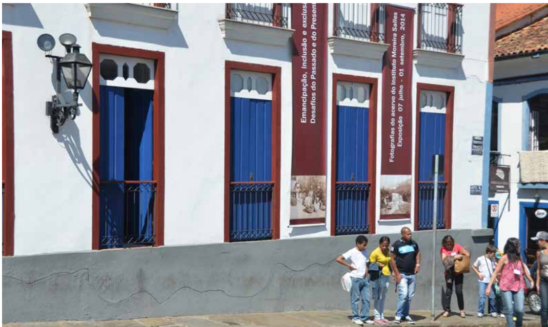
Figura 75 Fachada principal do sobrado reconstruído. No barrado nota-se o risco que aponta a altura dos vestígios originais da parede – ou seja, praticamente todo o edifício foi refeito Fonte: Rodrigo Baeta (2014).
