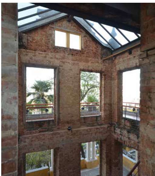
Figura 124 Interior do Palacete Murtinho Nobre – Parque das Ruínas Fonte: Rodrigo Baeta (2014).
