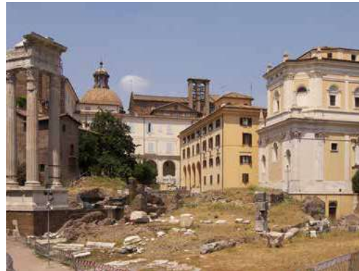
Figura 327 Santa Rita da Cascia, remontada, e seu novo vizinho: o isolado Teatro Marcello. Esta fachada lateral da igreja, tão exposta, não existia
