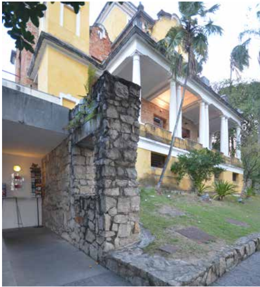
Figura 118 Fachada principal restaurada do Palacete Murtinho Nobre – Bairro de Santa Teresa, no Rio de Janeiro Fonte: Rodrigo Baeta (2014).
