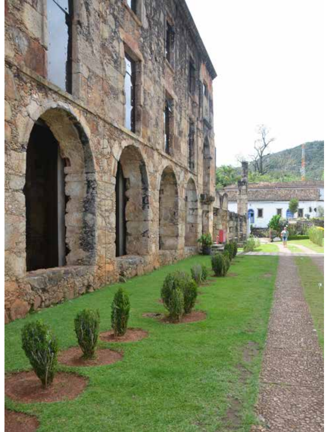
Figura 102 Uma das paredes exteriores da ruína requalificada, com destaque para a composição das esquadrias de vidro fumê dispostas por trás das paredes, no espaço interno do edifício Fonte: Rodrigo Baeta (2014).
