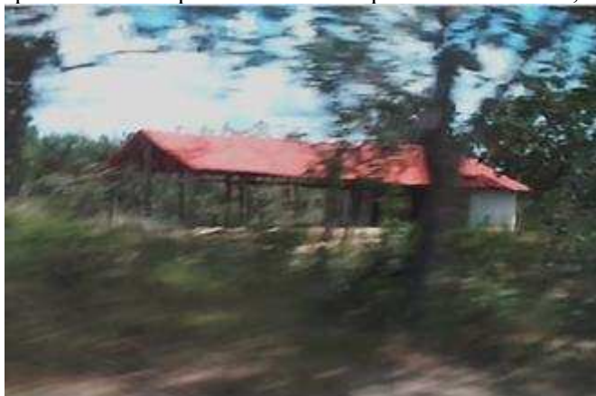
Figura 387 – Galpão construído para as artesãs do povoado de Porcos, em Cocos (Bahia).
