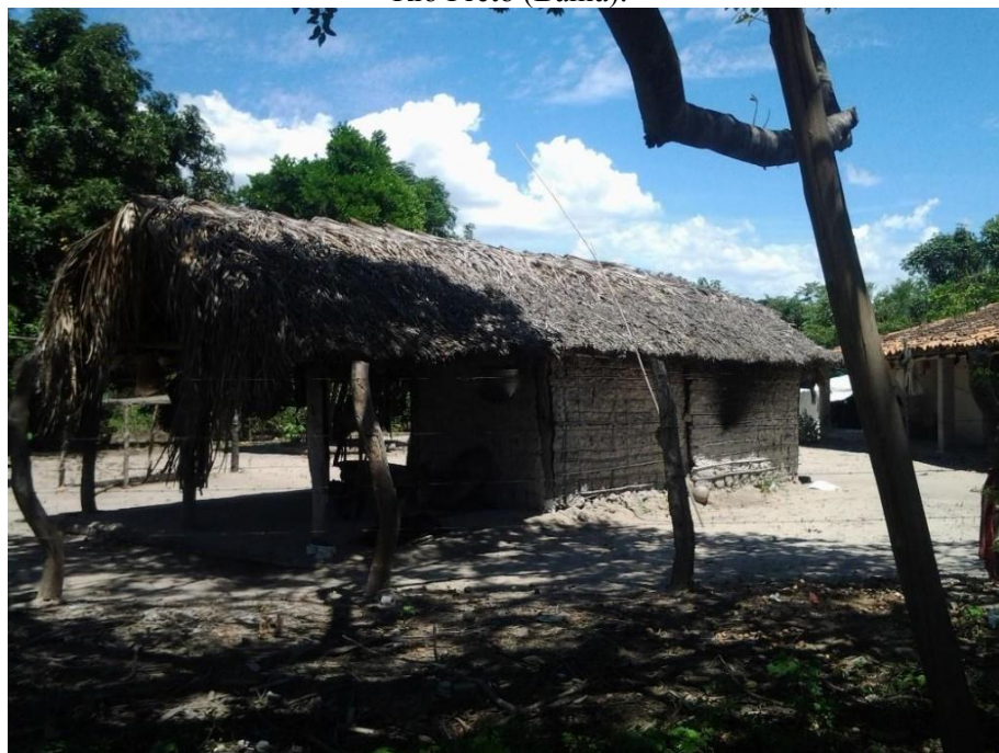
Figura 310 – Casa com telhado de palha do buriti. Comunidade de Cacimbinha, em Formosa do Rio Preto (Bahia).
