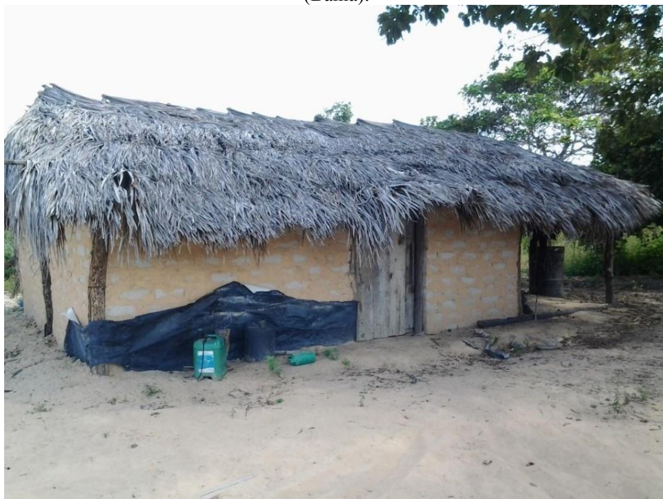
Figura 311 – Casa com telhado de palha do buriti. Povoado de Porcos, zona rural de Cocos (Bahia).
