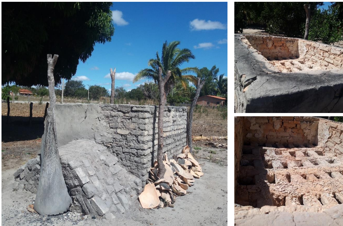
Figuras 243, 244 e 245 – Forno para queima de cerâmica no quintal da casa da artesã Leuza Maria da Conceição Souza, do povoado de Lamarão, em Baianópolis (Bahia). Na direita, detalhes da abertura superior do forno.
