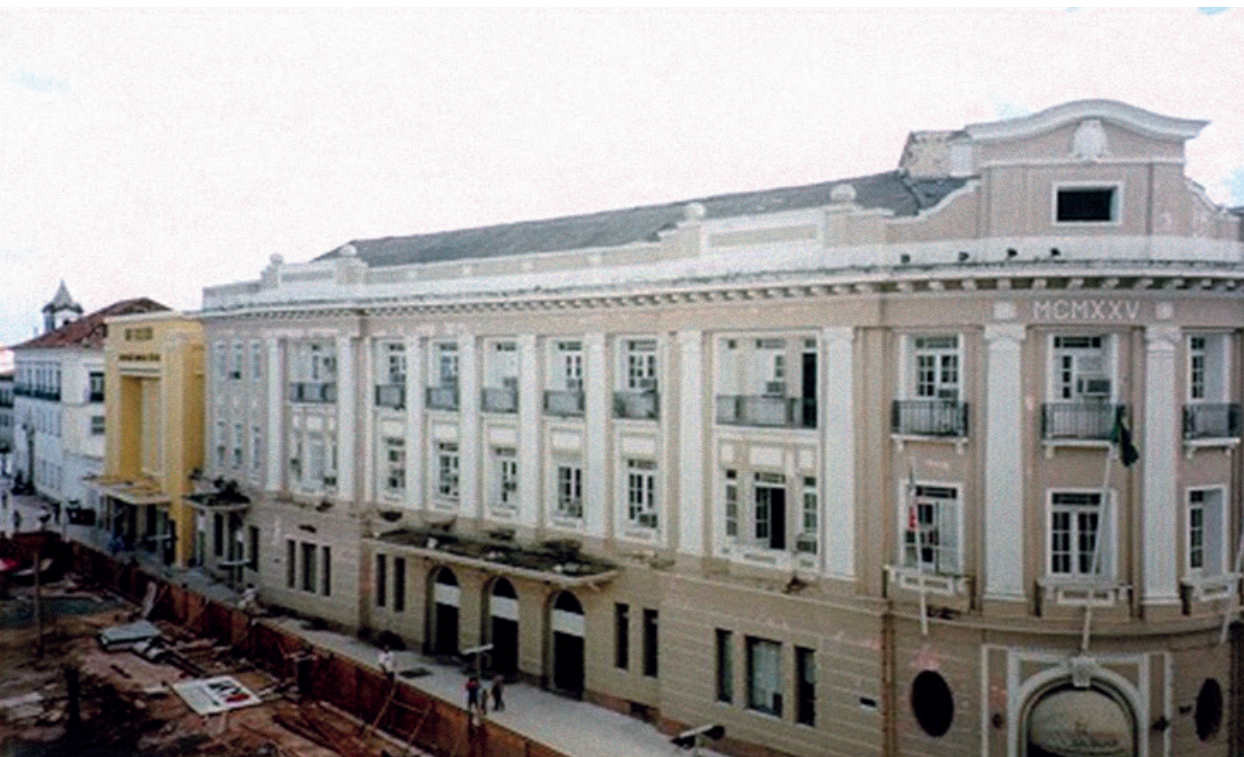
FIGURA 14. Prédios da Coelba e Cine Excelsior, prováveis locais de trechos do sítio onde foram construído os “Estudos Gerais”. Fotógrafo: Ubirajara D. Lemos
