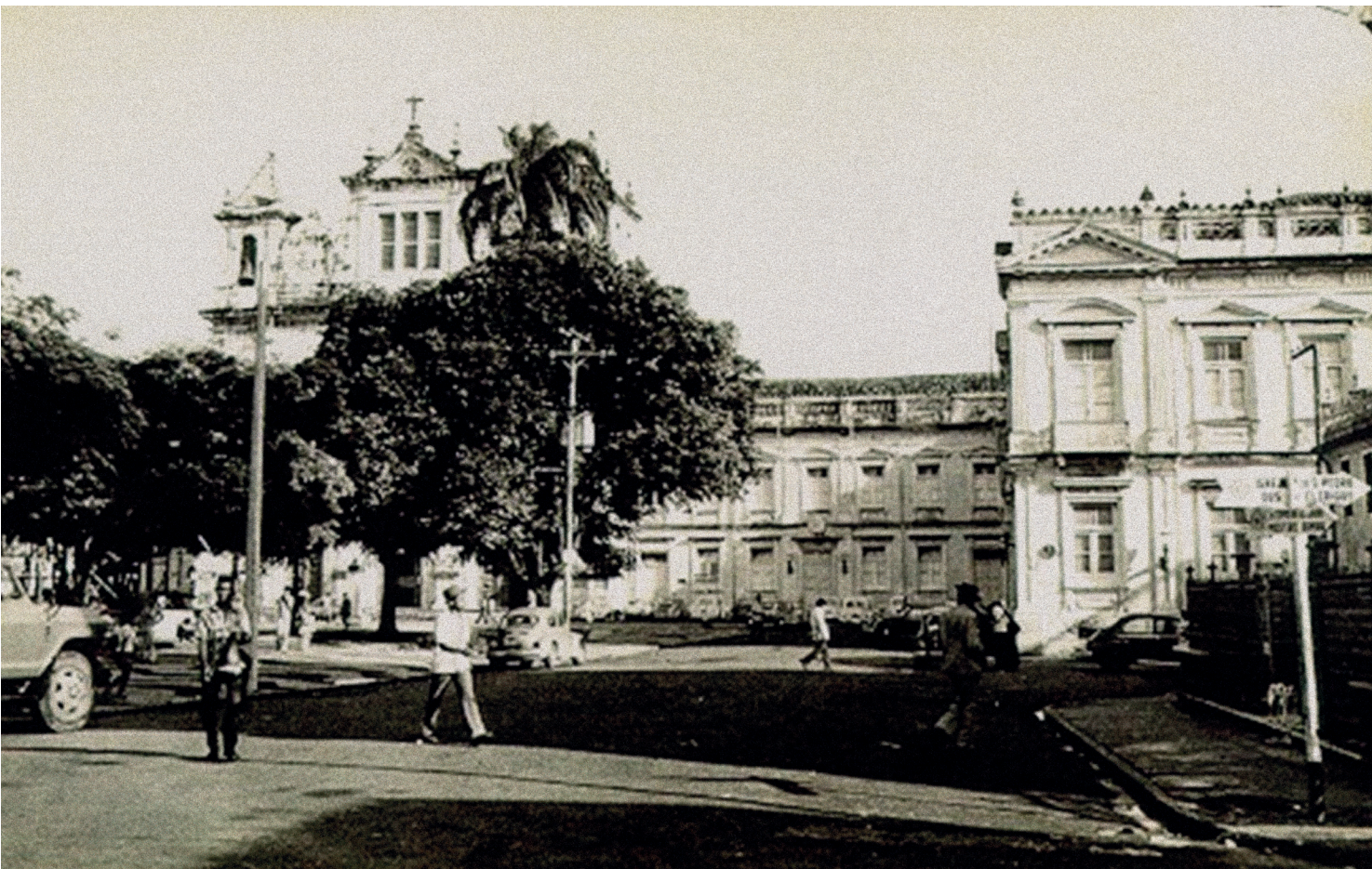
FIGURA 23. Vista Parcial do Prédio da Antiga Faculdade de Medicina. Fonte: FPACB, Projeto Museu Afro-Brasileiro.
