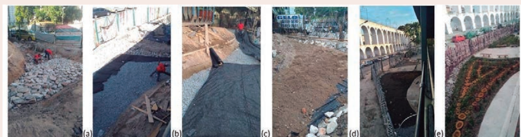
Figura 2. Passo-a-passo da implantação dos jardins de chuva na Fundição Progresso.
