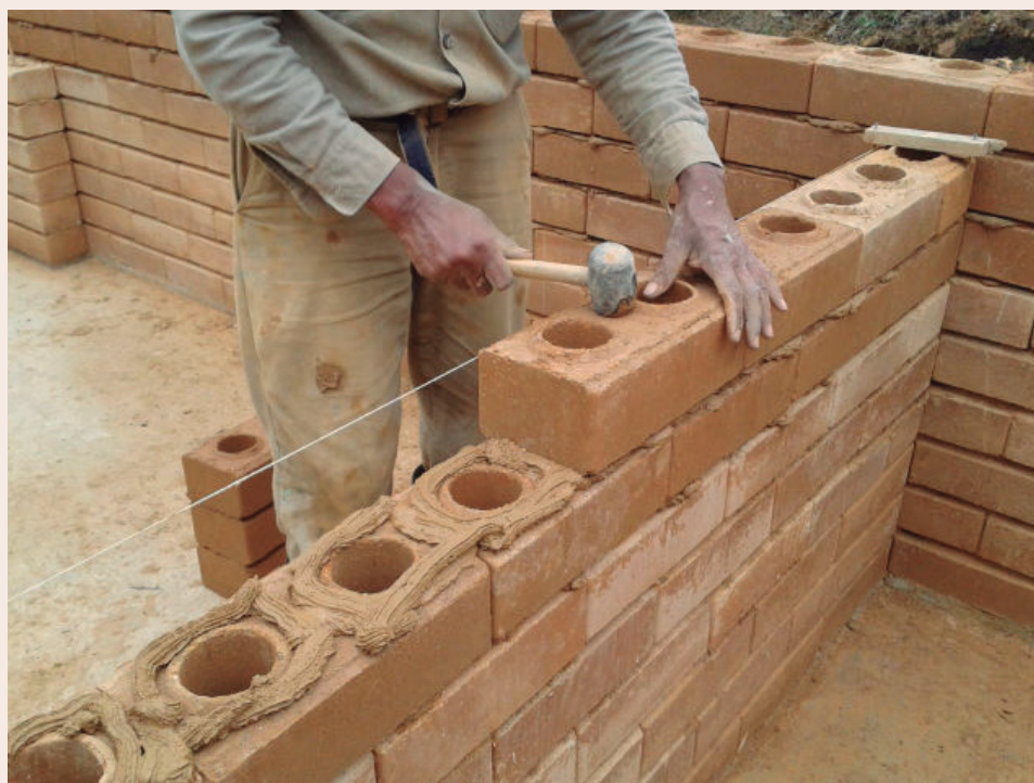
Figura 4. Construcción de un muro con bloques de tierra comprimida (BTC) en Federal, Entre Ríos
