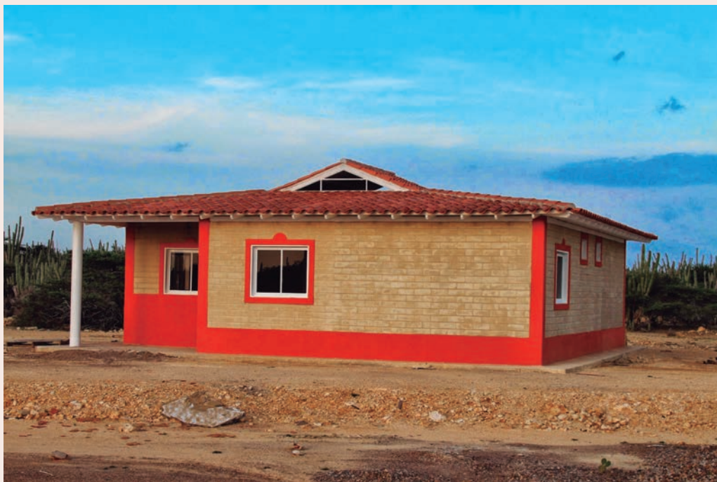
Figura 5. Vivienda construida con bloques de tierra comprimida (BTC) en la ciudad de Goya, Corrientes.
