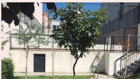
Figura 1. Porta de acesso à casa de bomba sob quadra esportiva e escada de acesso à quadra
