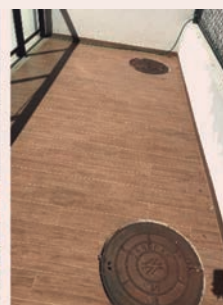
Figura 3. Casa de bombas
