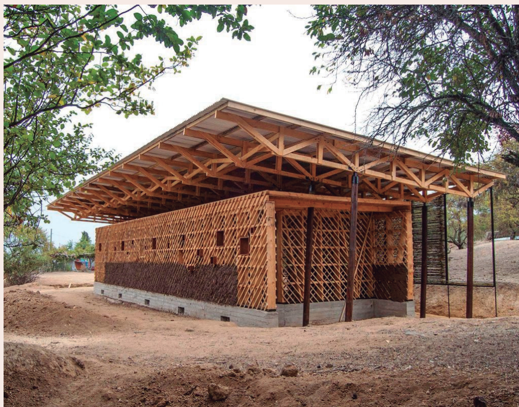
Figura 1. Embarrado de una vivienda construida con técnicas mixtas
