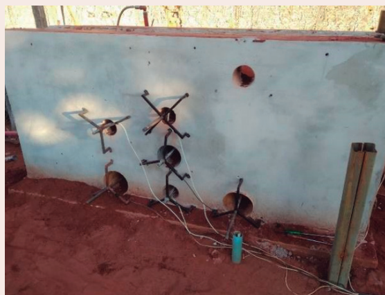
Figura 3. Suportes metálicos fixados no molde indeformável
