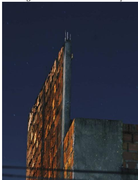
Figura 6 - Periferia em construção
