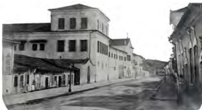
[67] Convento de N. Senhora das Mercês fachada primitiva
