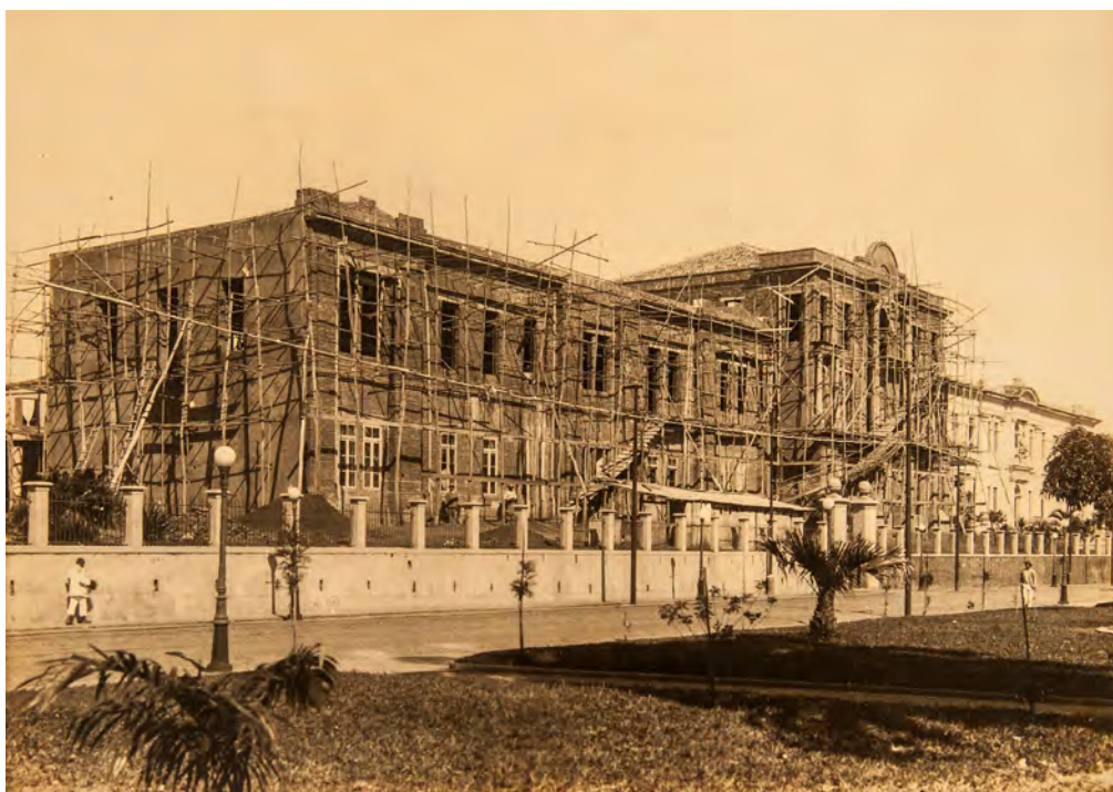
[152] Obras de ampliação do Liceu Salesiano de Salvador, 1926
