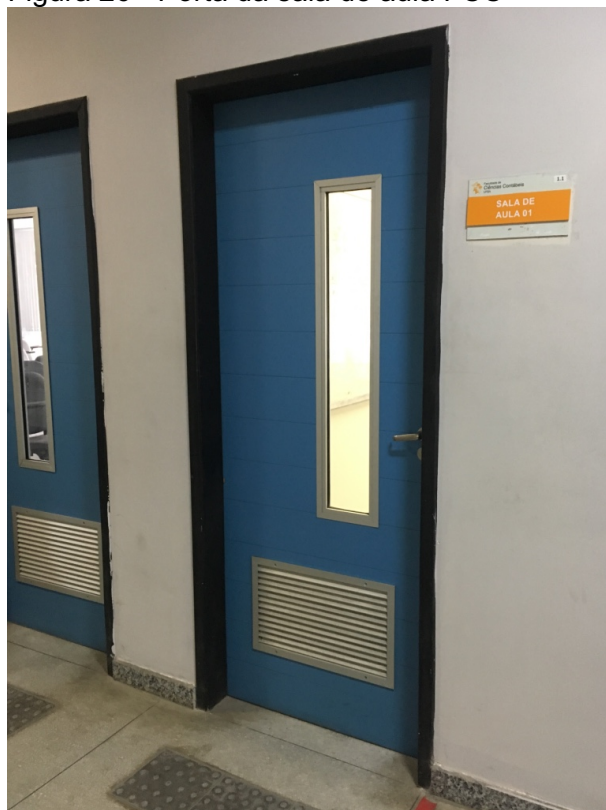
Figura 26 - Porta da sala de aula FCC
