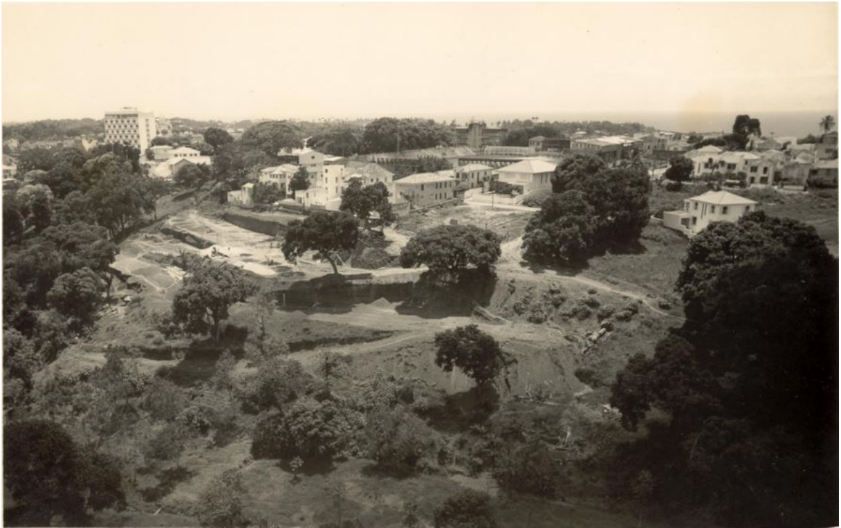
Figura 6 - A Roça da Graça. Movimento de terraplanagem para implantação da Faculdade de Direito e via de acesso.
