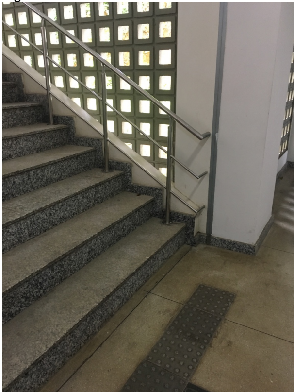
Figura 16 - Escada da FCC
