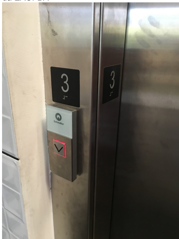
Figura 34 - Sinalização externa no elevador da EAUFBFA
