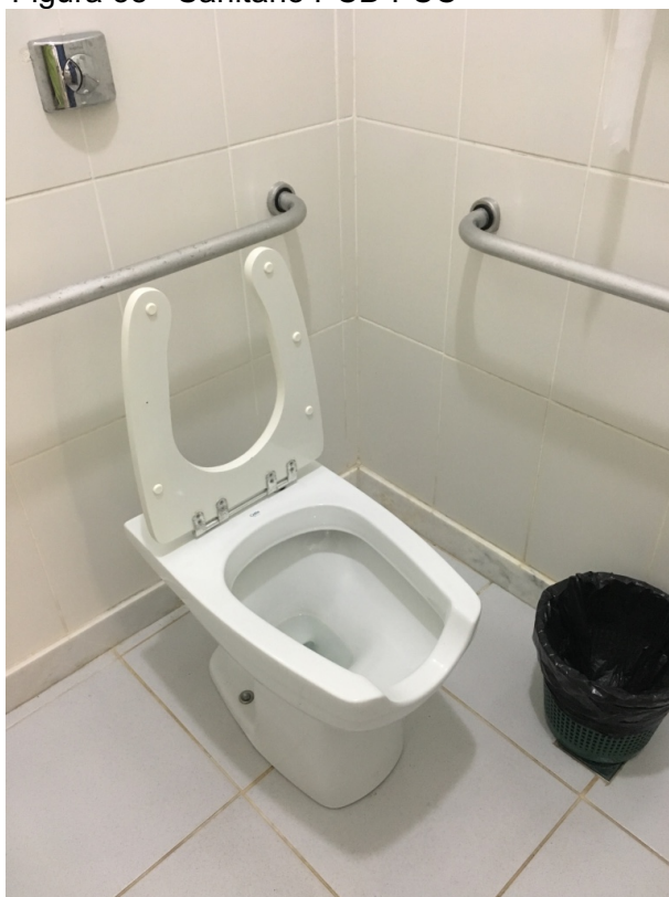
Figura 38 - Sanitário PCD FCC
