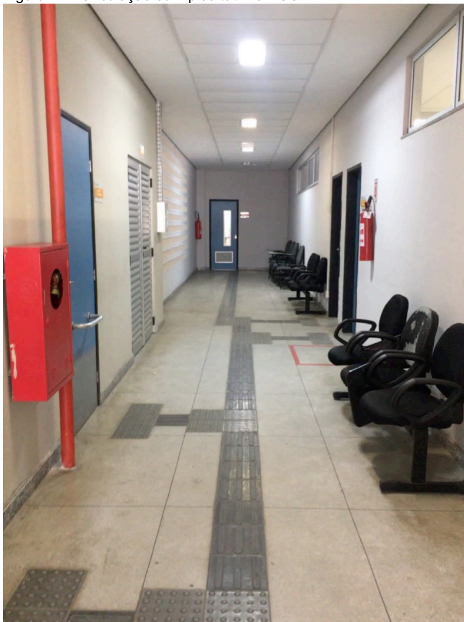
Figura 14 - Circulação com piso tátil na FCC
