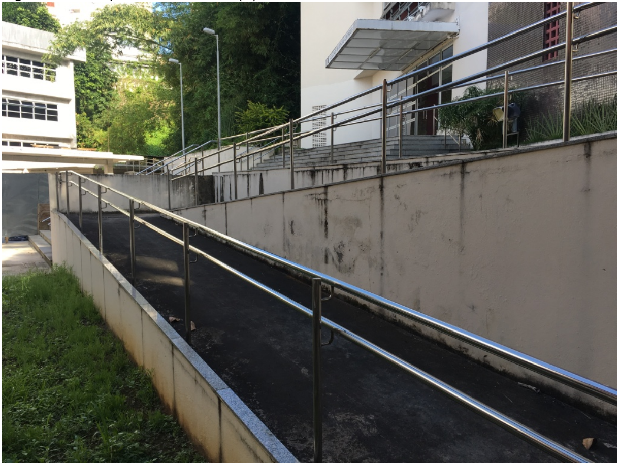
Figura 24 - Rampa de acesso FCC (B)
