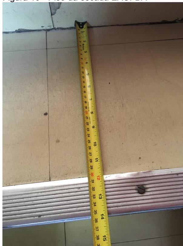
Figura 19 - Piso da escada EAUFBFA
