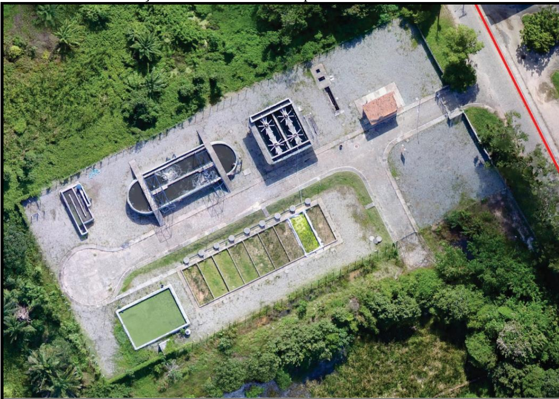
Foto 6 - Vista Aérea da Estação de Tratamento no Campus São Cristóvão
