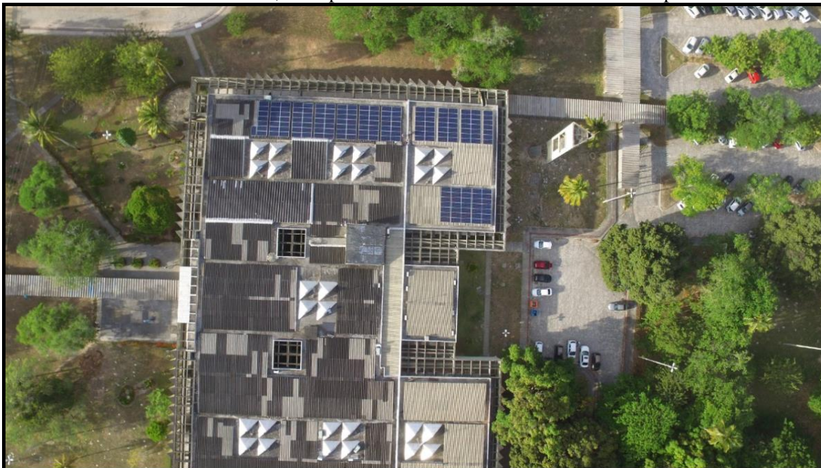
Foto 11 - Sistema Fotovoltaico 58,96kWp na Biblioteca Central – BICEN no Campus São Cristóvão
