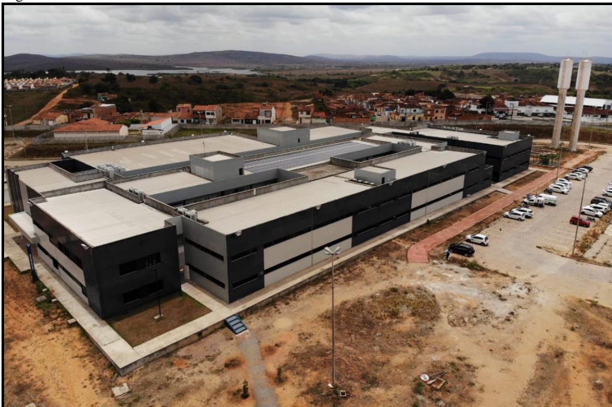
Foto 18 - Sistema Fotovoltaico 66kWp no Centro de Simulações e Práticas da Saúde do Campus Lagarto
