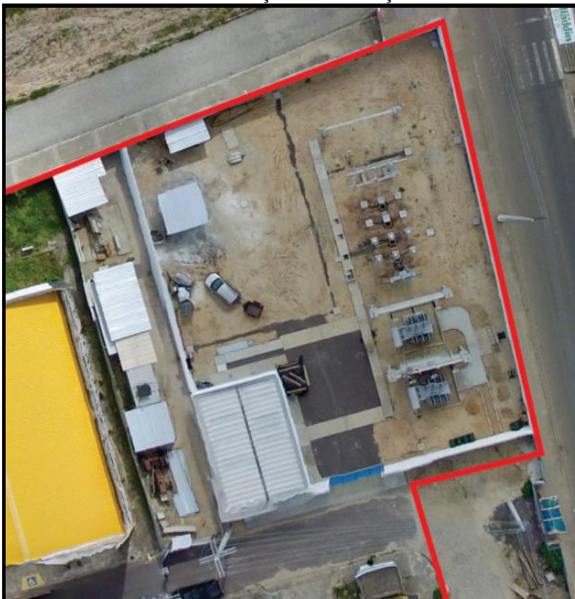
Foto 8 - Vista Aérea da construção da Subestação Elétrica - SE UFS 69kV no Campus São Cristóvão
