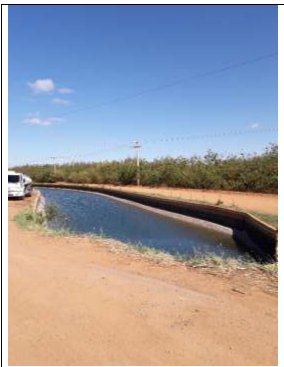
Figura 13 – Canal de irrigação do projeto da CODEVASF em Juazeiro
