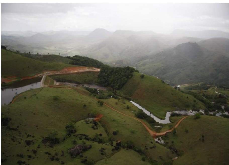
Figura 2. PCH Cachoeira da Lixa (14,8 MW), extremo sul da Bahia Fonte: Renova Energia.
