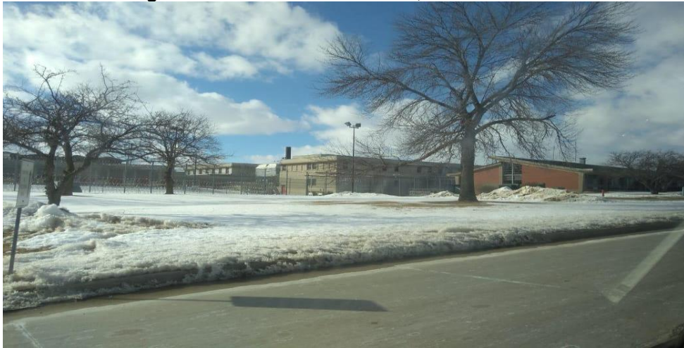
Figura 16 - Área externa do IMCC, inverno de 2019
