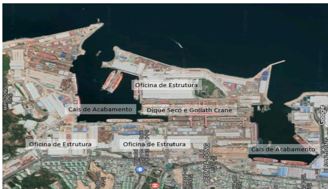
Figura 7 – Estaleiro offshore da Hyundai em Jeonha/Coreia do Sul com três diques secos
