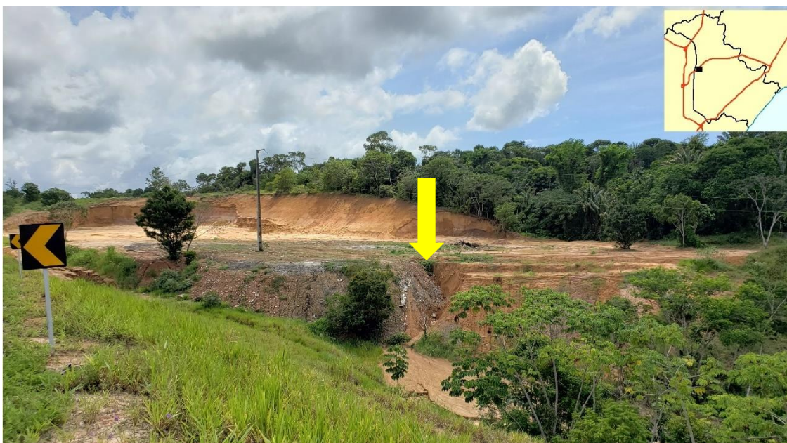
Figura 107 – Processo de erosão próximo a área de solo exposto para construção civil em app de curso d'água de 30 metros no Rio do Cají, para implantação de um posto de combustível, no sentido para Camaçari na via Metropolitana em Lauro de Freitas, em 13/02/2020
