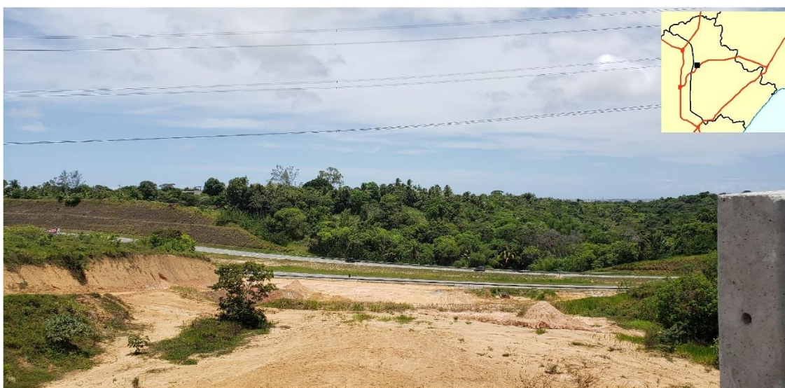
Figura 103 – Área de nascente e app de 30 metros com solo exposto para construção civil, vista de cima, para implantação de um posto de combustível, em Lauro de Freitas, no sentido para Salvador na via Metropolitana, em 15/11/2020
