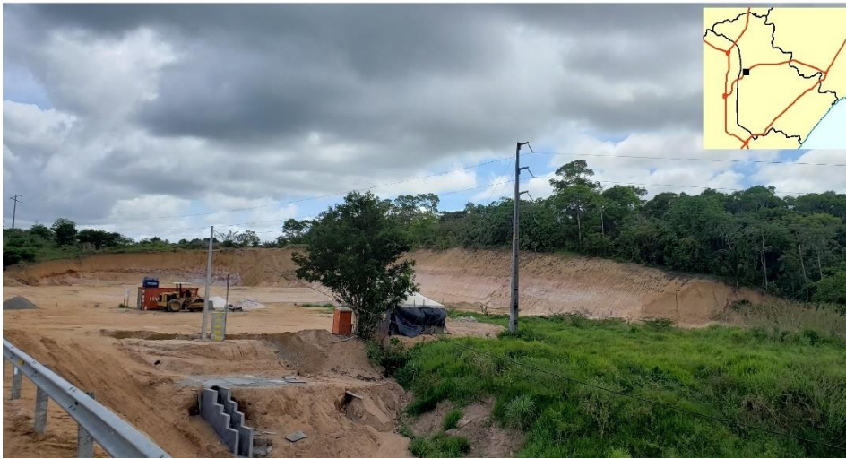
Figura 21 - Construção de posto de combustível na via Metropolitana em Lauro de Freitas no estado da Bahia, 2020
