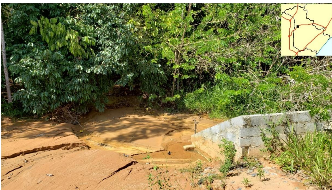
Figura 99 – Área de nascente próxima a área de solo exposto para construção civil para implantação de um posto de combustível, em Lauro de Freitas, no sentido para Salvador na via Metropolitana, em 13/02/2020
