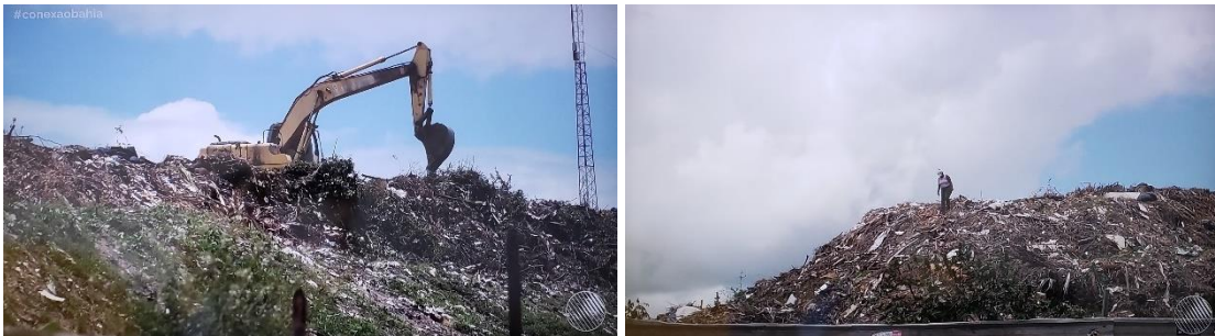
Figura 26 –Lixão do Quingoma localizado no núcleo de povoamento Quingoma de Fora , no bairro do Quingoma, no município de Lauro de Freitas em 2021, Bahia
