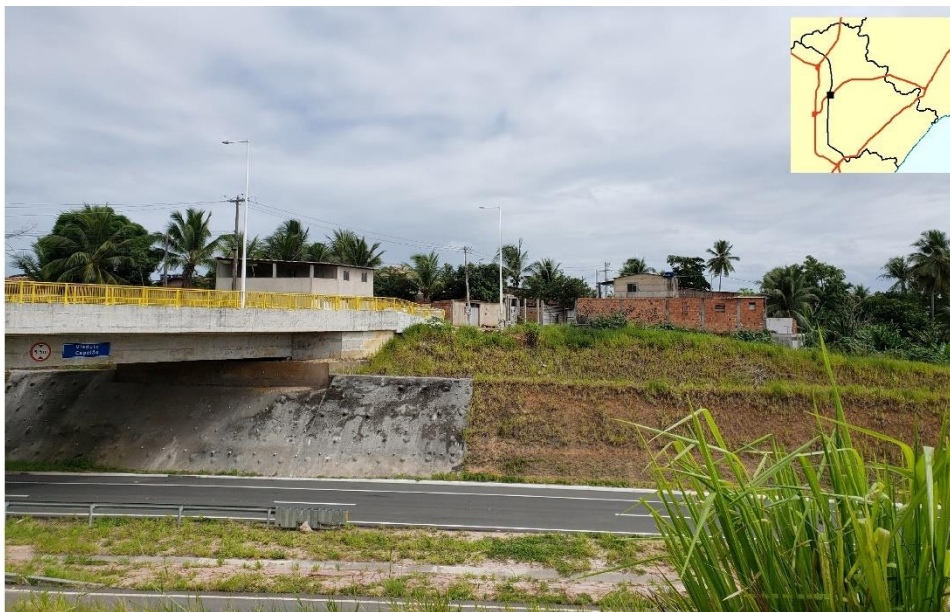
Figura 22 – Áreas ocupadas/edificadas ao longo da via Metropolitana em Salvador em 2020
