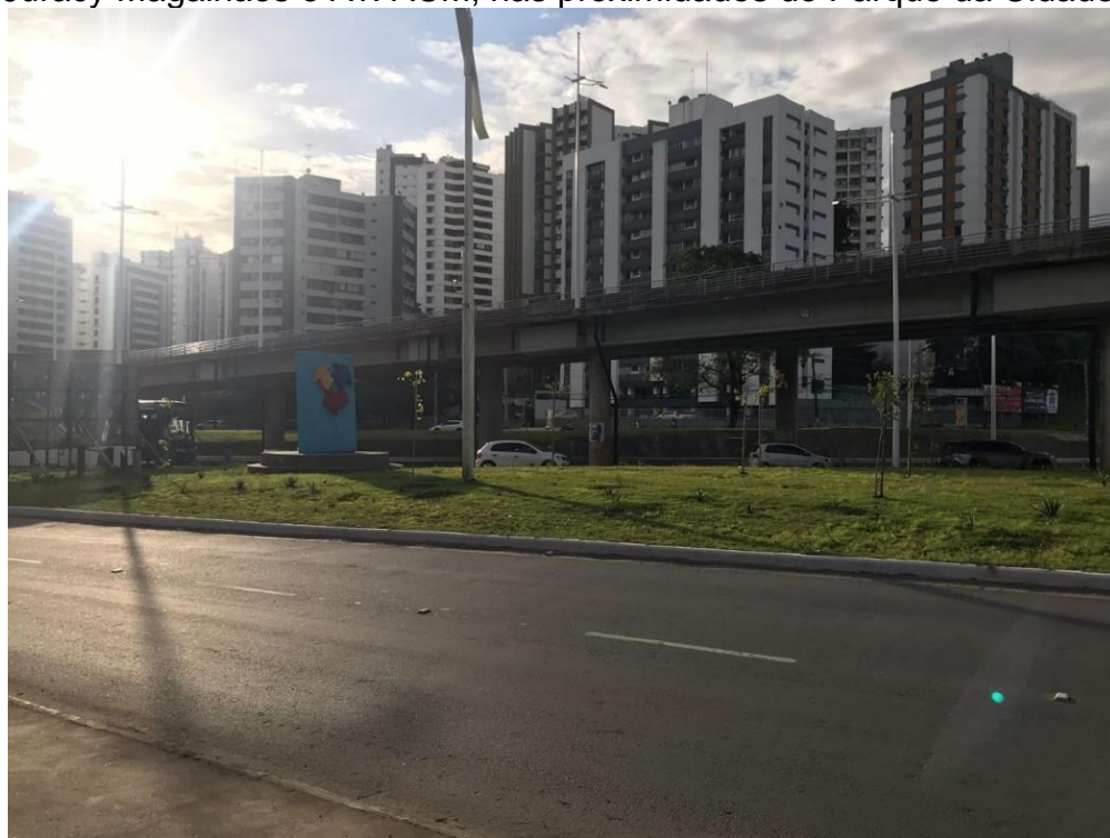
Figura 7. AV. ACM, no Itaigara, depois das obras de infraestrutura, na interseção entre as Av. Juracy Magalhães e Av. ACM, nas proximidades do Parque da Cidade
