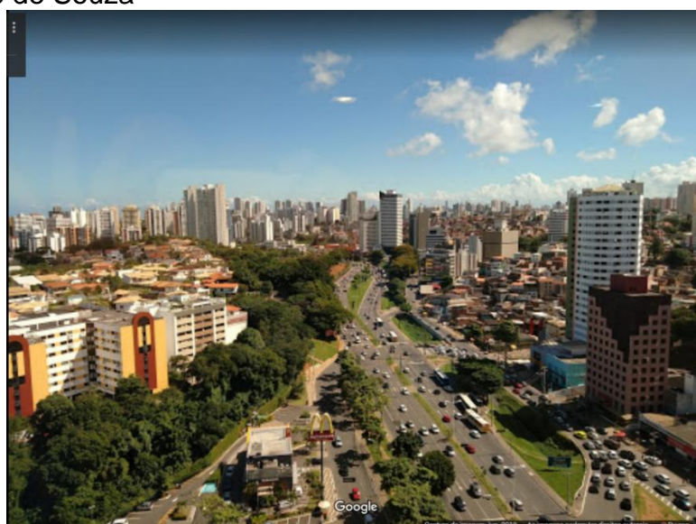
Figura 10. Av. ACM, no Iguatemi, antes das obras de infraestrutura, próximo ao Edifício Thomé de Souza
