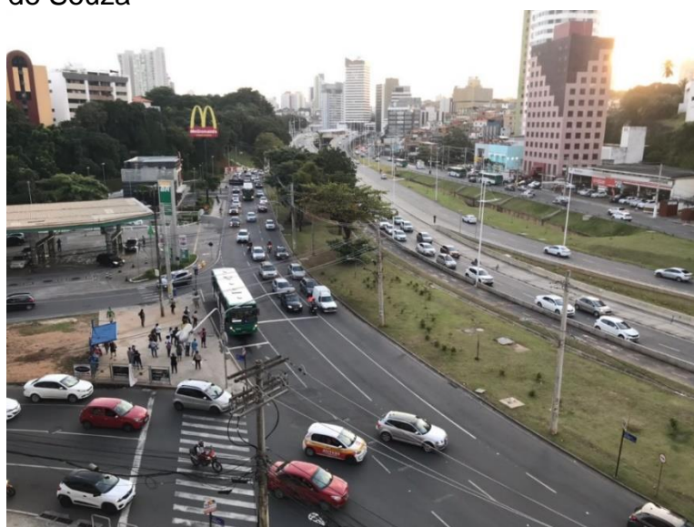
Figura 11. Av. ACM, no Iguatemi, depois das obras de infraestrutura, próximo ao Edifício Thomé de Souza
