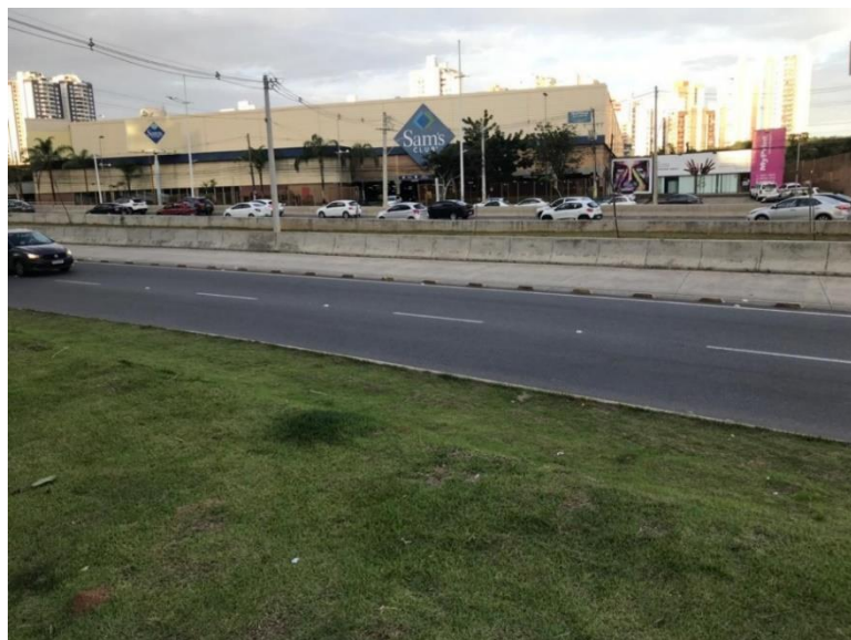
Figura 13. Av. ACM, no Iguatemi, depois das obras de infraestrutura, próximo ao Sam's Club
