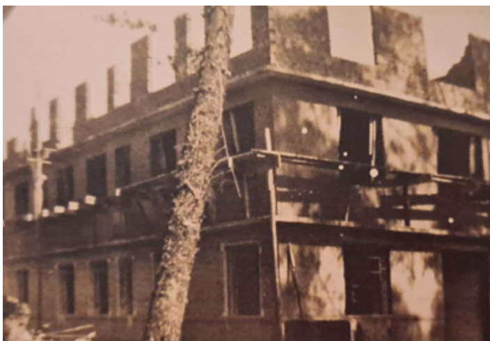
Figuras 3, 4 e 5 – Obras do Hospital Aristides Maltez Fonte: Sampaio (2006).
