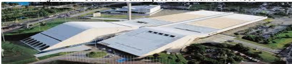
Figura 14 – Centro de Convenções de Pernambuco – 1980
