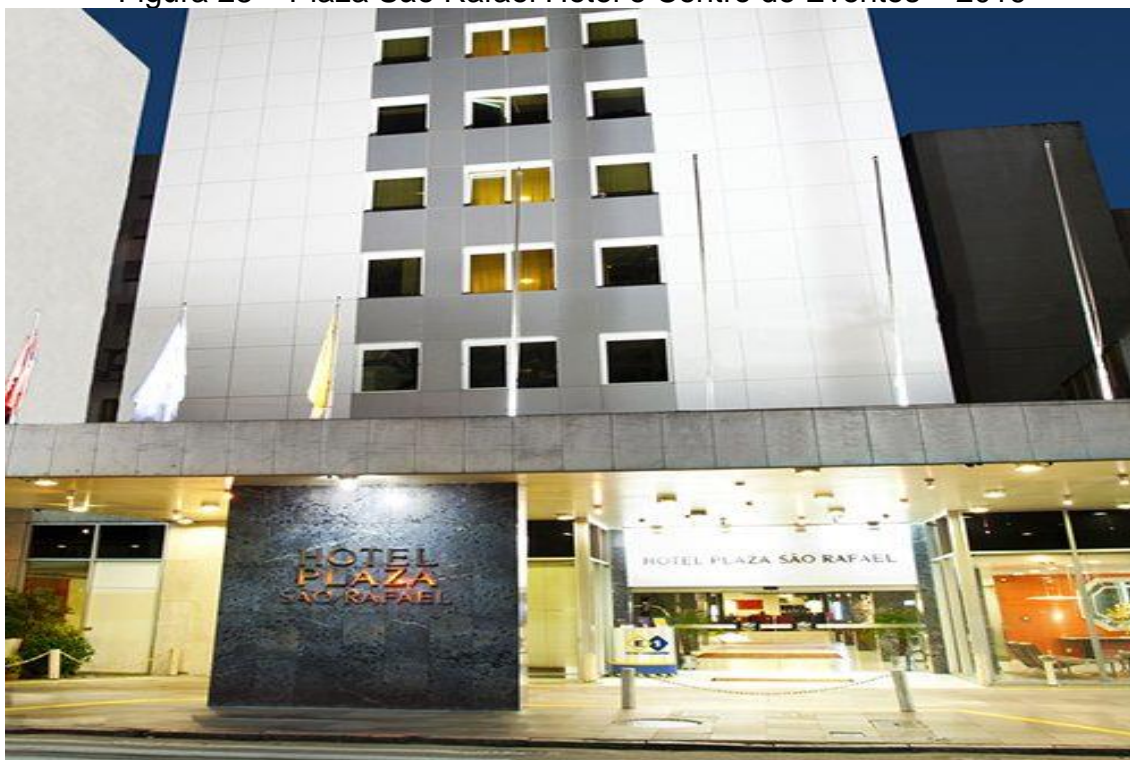
Figura 28 – Plaza São Rafael Hotel e Centro de Eventos – 2019
