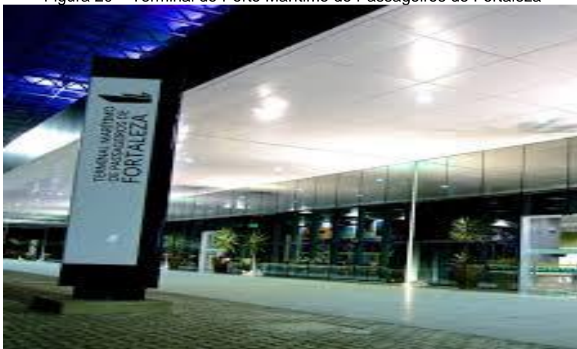
Figura 20 – Terminal do Porto Marítimo de Passageiros de Fortaleza
