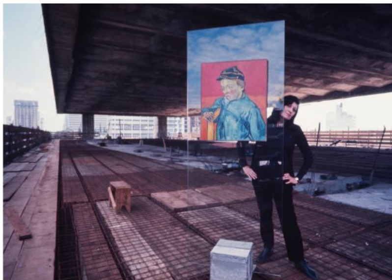
Figura 24 — Lina Bo Bardi e Cavalete de Cristal no MASP em construção.
