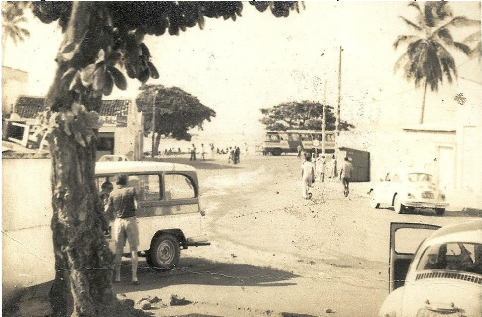
Figura 51 - Trecho da Avenida Dorival Caymmi, antes do processo de duplicação
