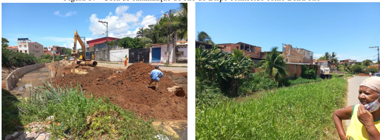
Figura 87 - Obra de canalização do Rio do Bispo conhecido como Beira-Rio
