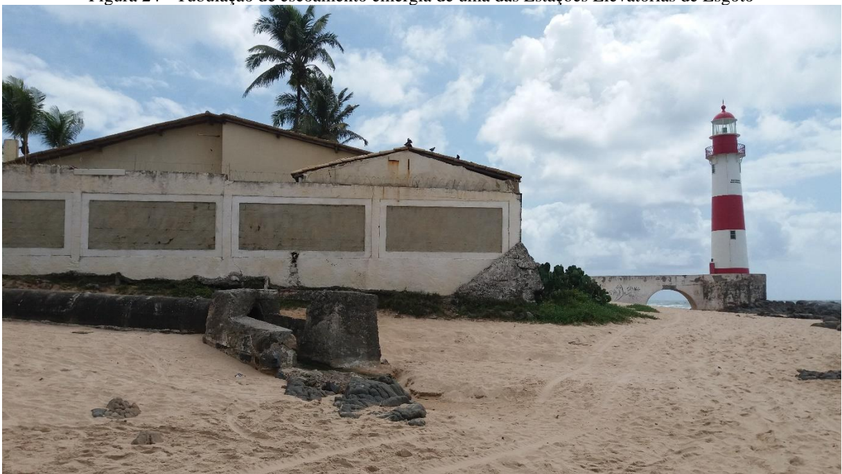
Figura 24 - Tubulação de escoamento emergia de uma das Estações Elevatórias de Esgoto
