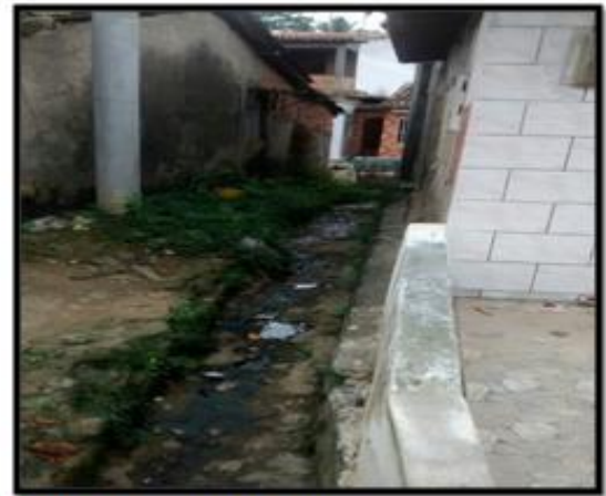
FIGURA4: Esgoto a céu aberto.
