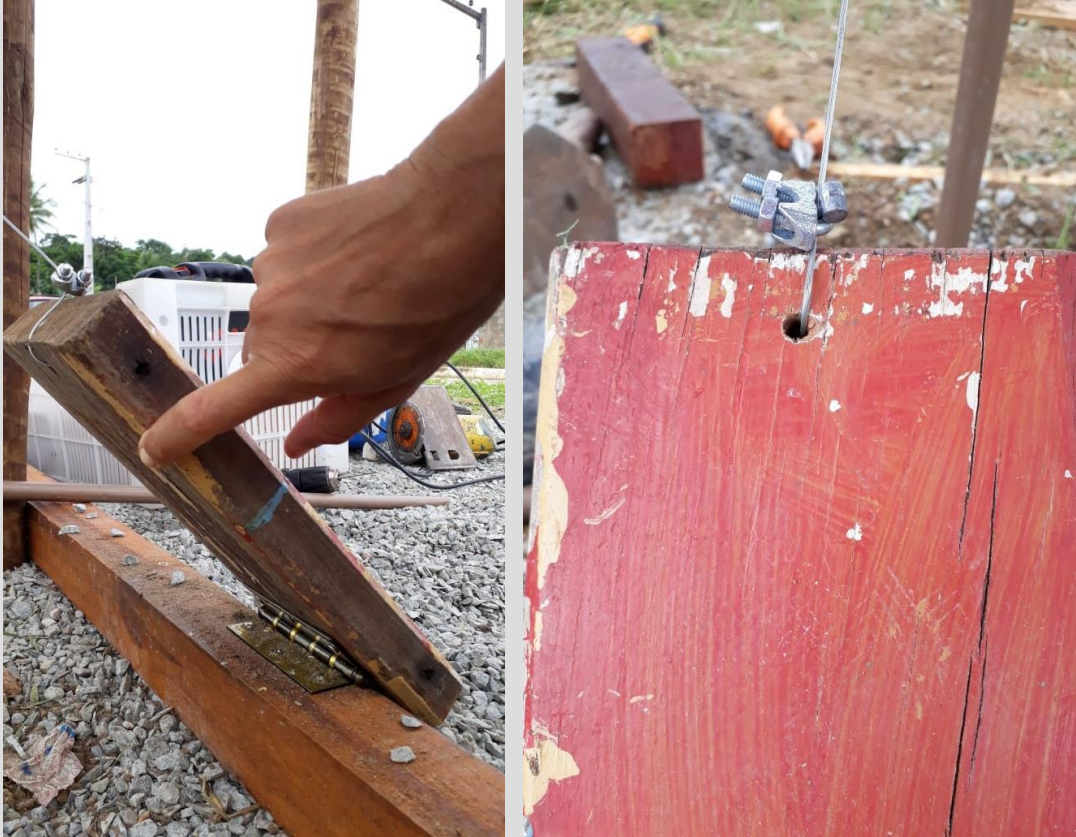
Detalhe do funcionamento com cabo de aço e mola fixado ao registro de esfera
