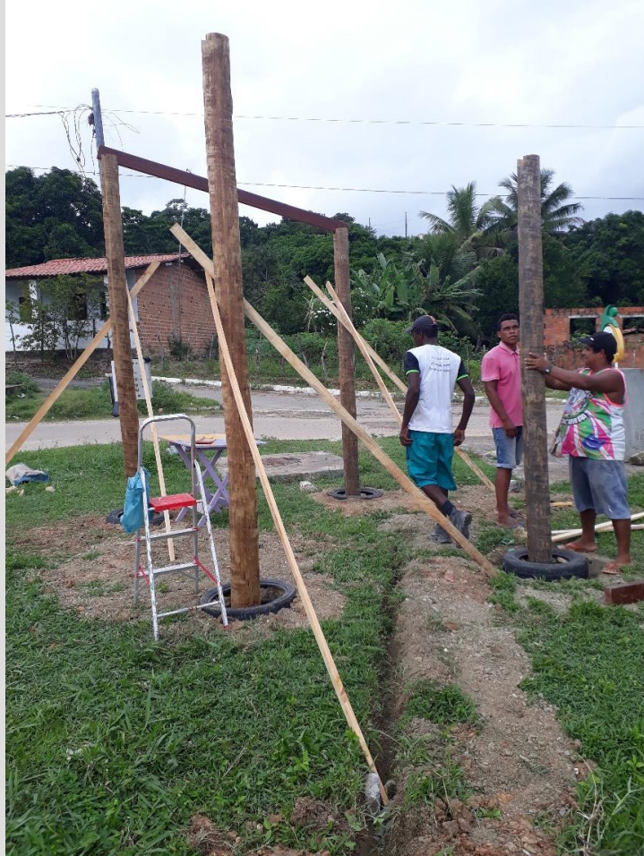
Montagem estrutura do cobertura
