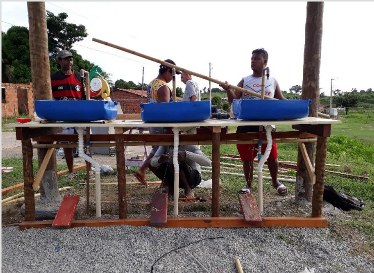
Montagem estrutura do cobertura
