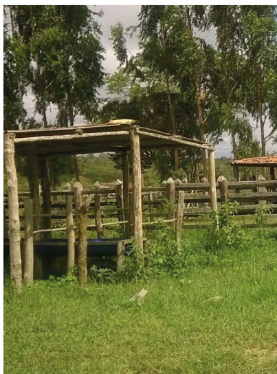
FIGURA 1.2 – Tipo de cobertura para proteção do cocho colocado em ambientes abertos Fonte: acervo pessoal de Edgar Faria.
