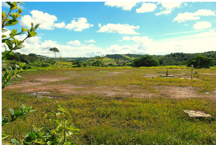
Unidade de bombeio desativada. Foto: Autora, 2022
