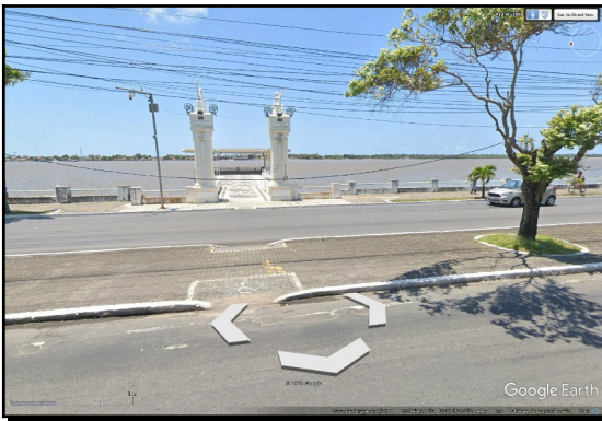
Figura 24: Entrada da Ponte do Imperador.
