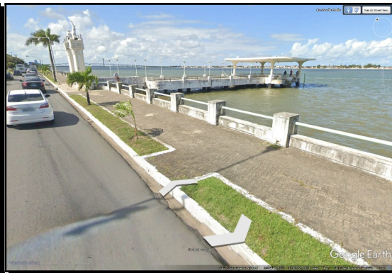
Figura 25: Lateral da Ponte do Imperador.
